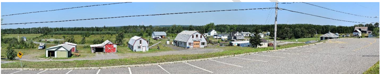
Photographie postconstruction – juillet 2018
