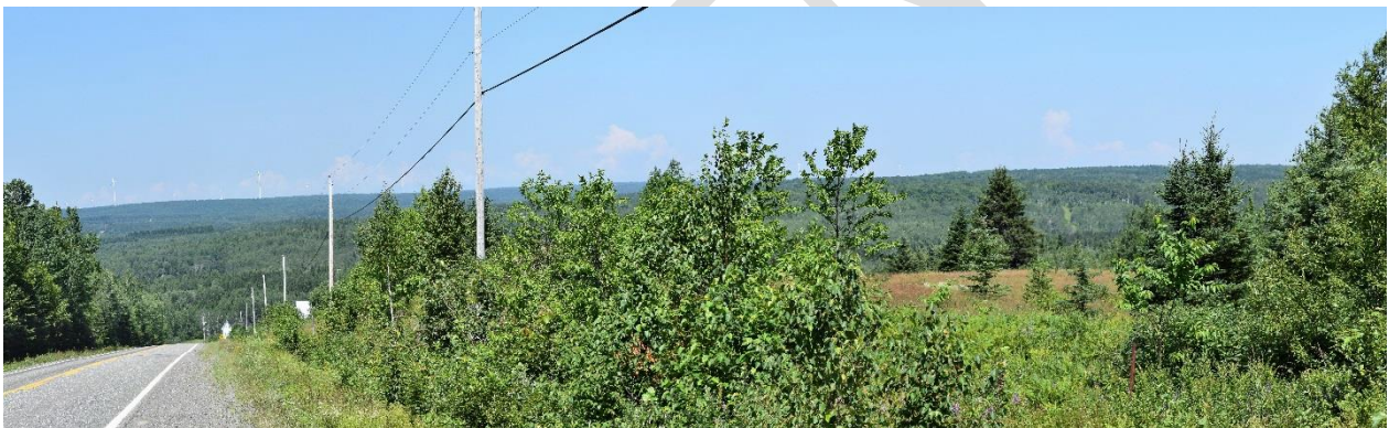
Photographie postconstruction – juillet 2018
