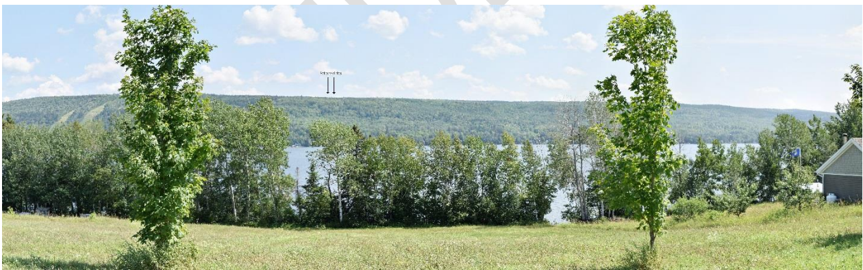
Photographie postconstruction – juillet 2018
