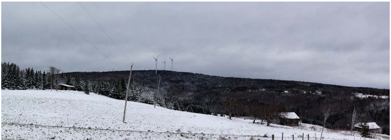
Photographie postconstruction – novembre 2018
