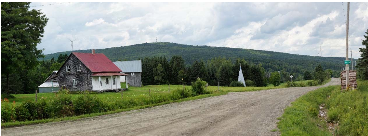
Photographie postconstruction – juillet 2018
