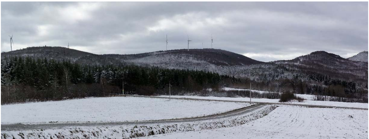
Photographie postconstruction – novembre 2018
