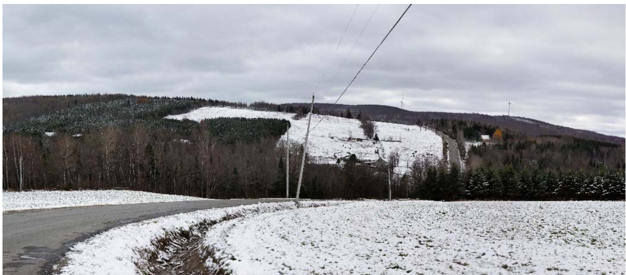
Photographie postconstruction – novembre 2018
