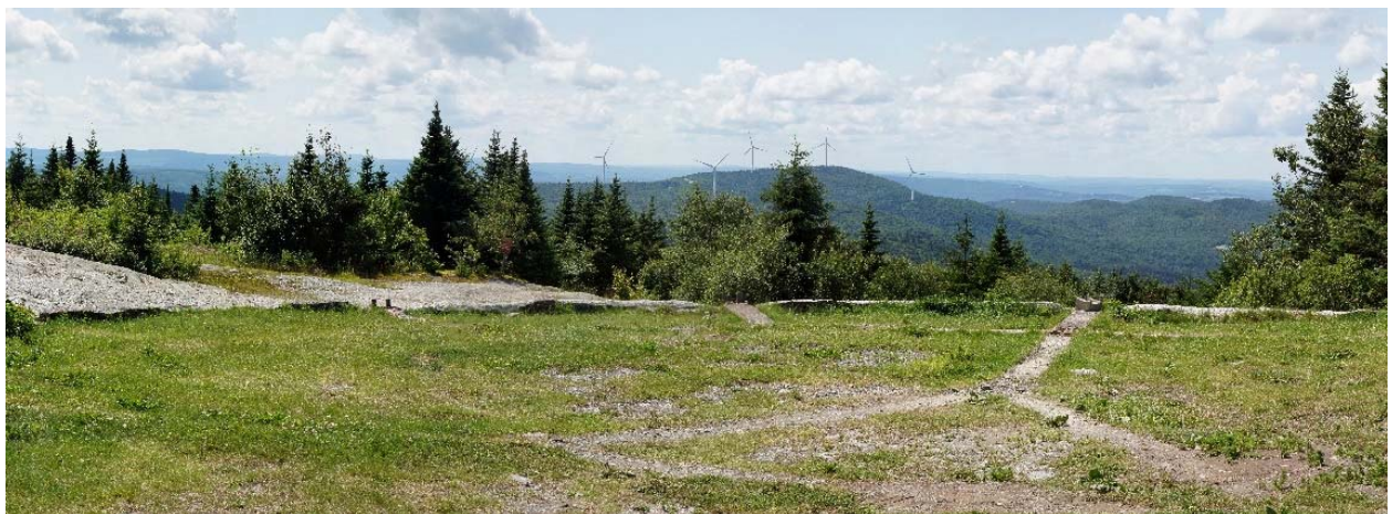
Photographie postconstruction – juillet 2018
