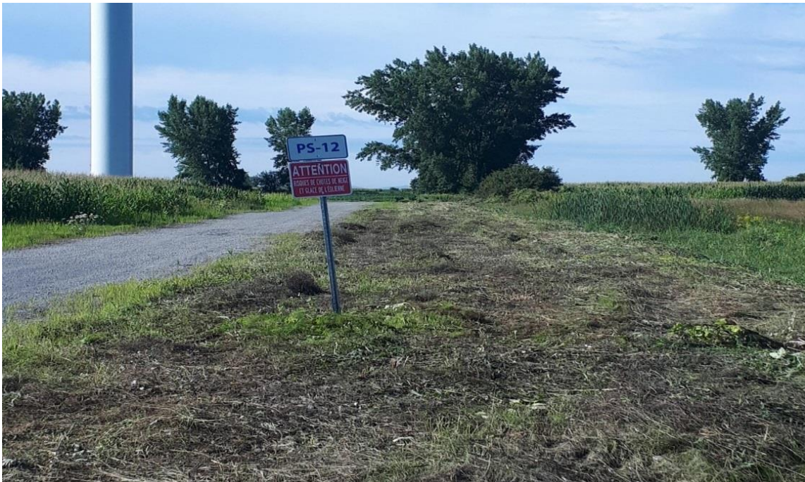
Chemin d'accès PS-12 côté droit.
