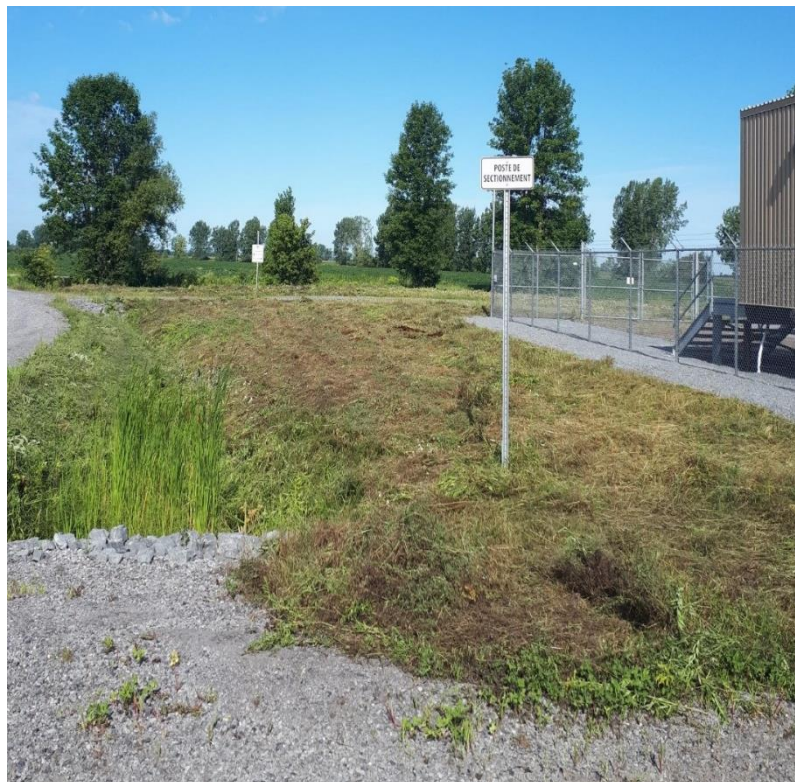
Poste de sectionnement.
