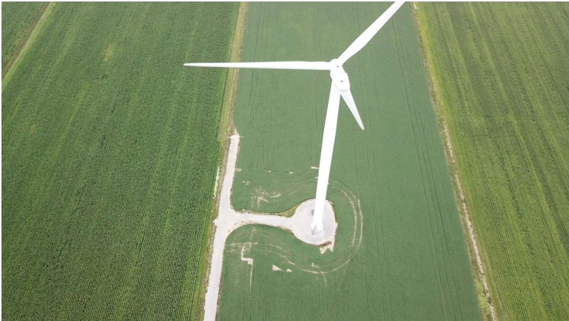
Photo de drone de la PS01 (04 août 2022) – OPSIS, Solutions Écoénergétiques
