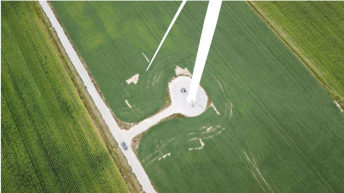
Photo de drone de la PS02 (04 août 2022) – OPSIS, Solutions Écoénergétiques
