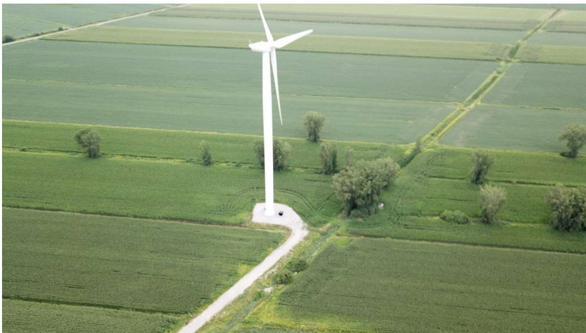
Photo de drone de la PS11 (04 août 2022) – OPSIS, Solutions Écoénergétiques
