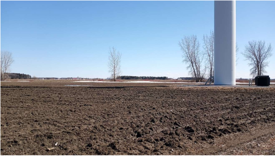
Photo 1 – champ proche de la PS12 qui a été nivelée en 2021 (05 avril 2022) – pas d’accumulation d’eau
