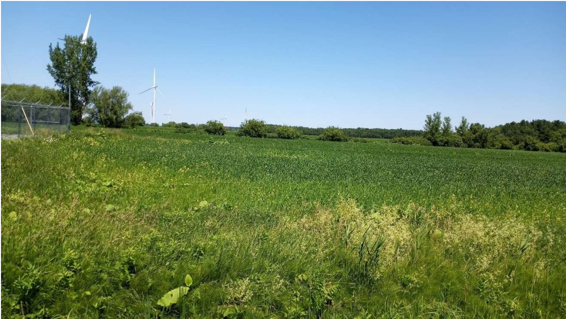
Photo 1– champ contigu au poste de sectionnement (20 juin 2022)
