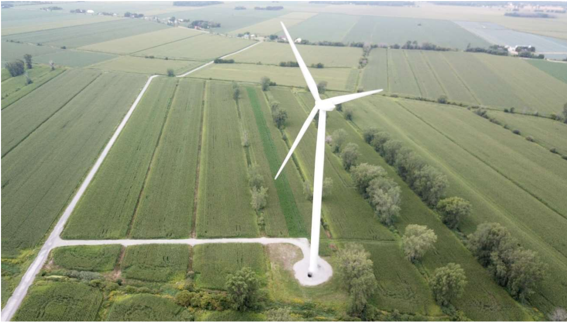
Photo de drone de la PS04 (04 août 2022) – OPSIS, Solutions Écoénergétiques
