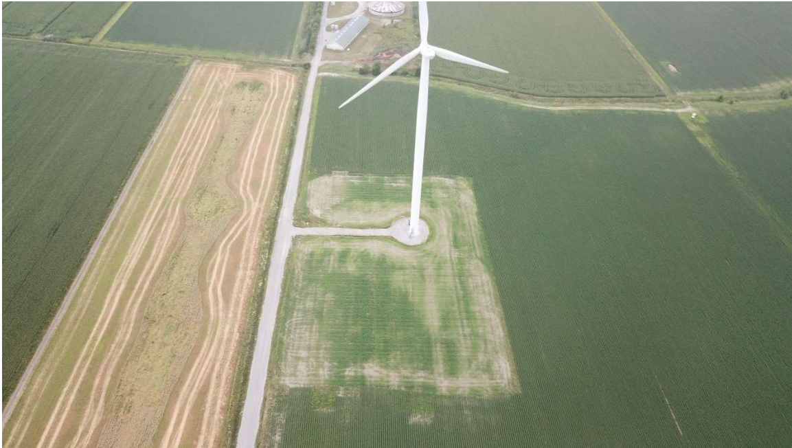
Photo de drone de la PS05 (04 août 2022) – OPSIS, Solutions Écoénergétiques
