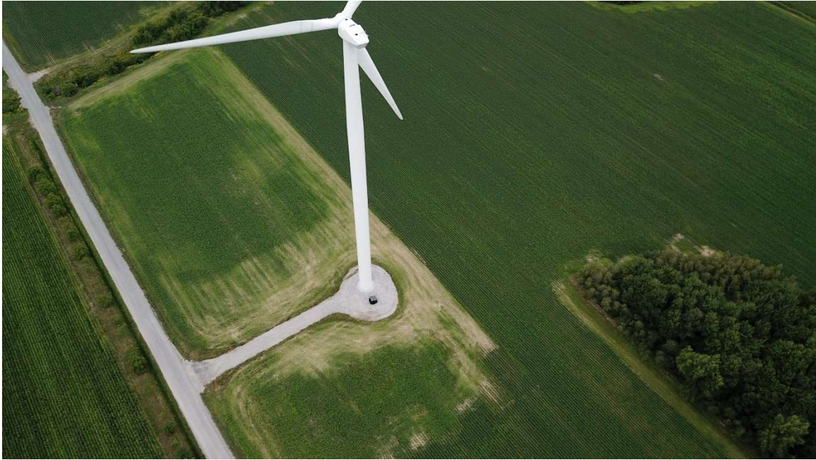
Photo de drone de la PS07 (04 août 2022) – OPSIS, Solutions Écoénergétiques.
