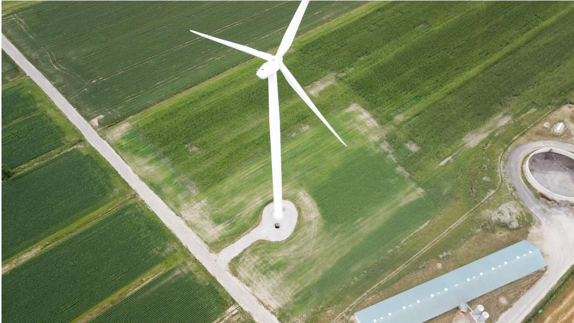
Photo de drone de la PS08 (04 août 2022) – OPSIS, Solutions Écoénergétiques
