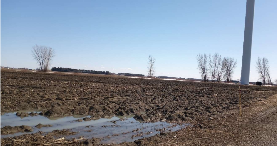
Photo 2 – légère accumulation d’eau proche du chemin en allant vers la PS12 ( 05 avril 2022) – champ près du chemin Brouillard
