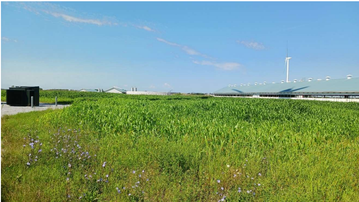
Photo 7– Sorgho entre la PS08 et les bâtiments(04 août 2022) - côté gauche
