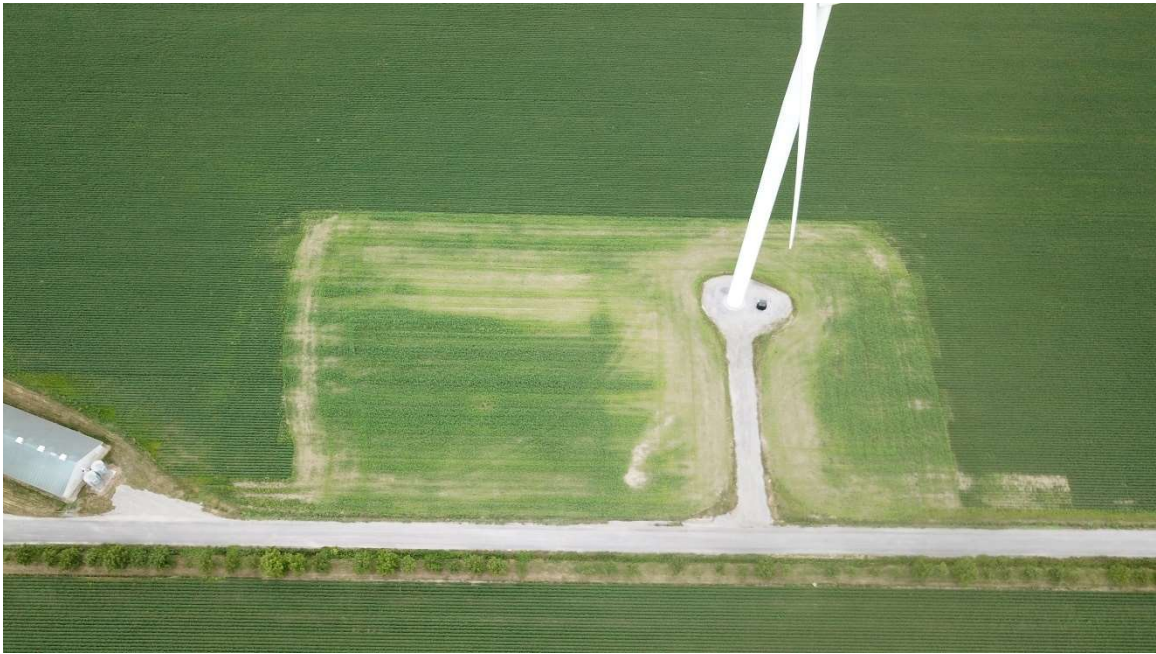
Photo de drone de la PS06 (04 août 2022) – OPSIS, Solutions Écoénergétiques
