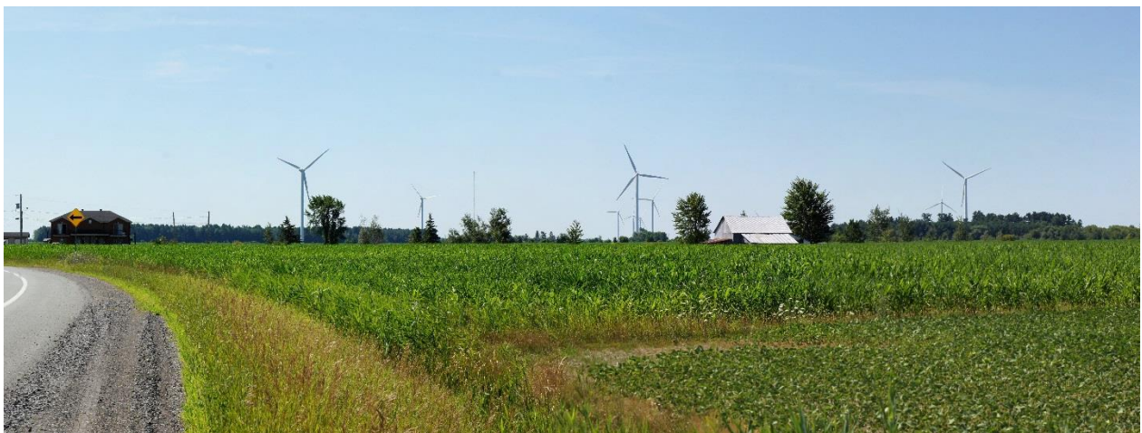
Photographie postconstruction – juillet 2018
