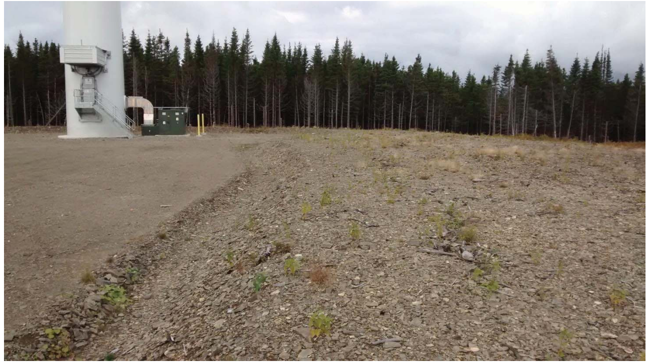
SITE : Éolienne 9 PROPORTION COUVERTE : 79 %
