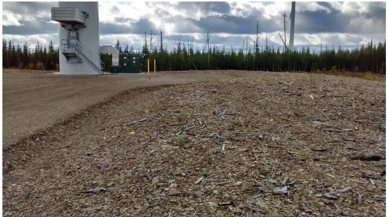
SITE : Éolienne 23 PROPORTION COUVERTE : 91 %
