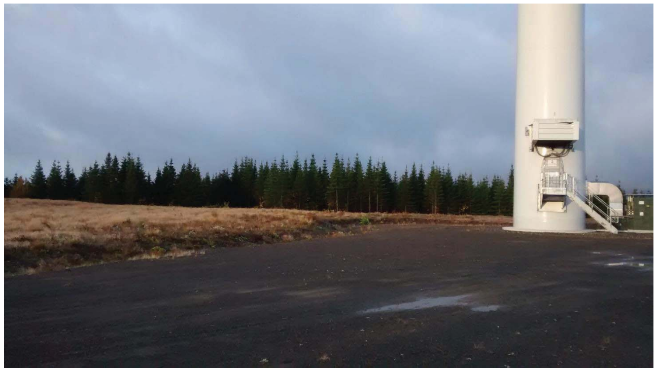
SITE : Éolienne 2 PROPORTION COUVERTE : 94 %
