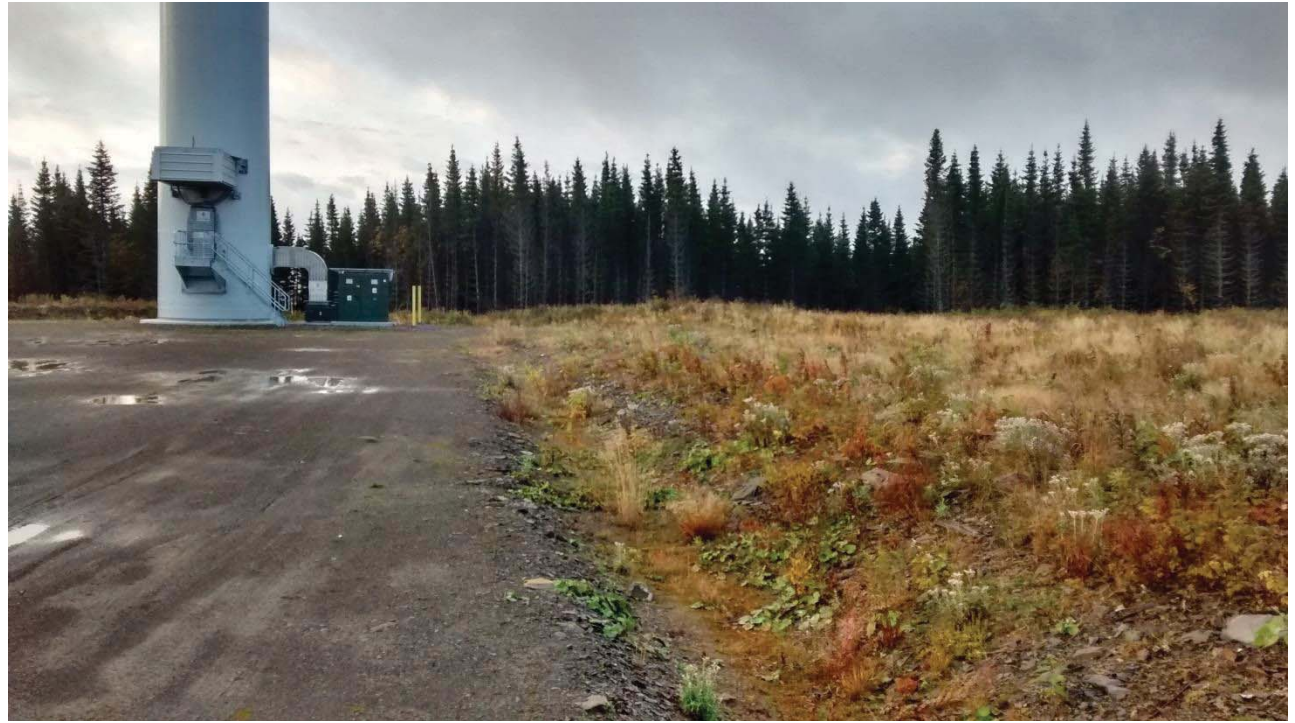
SITE : Éolienne 4 PROPORTION COUVERTE : 78 %
