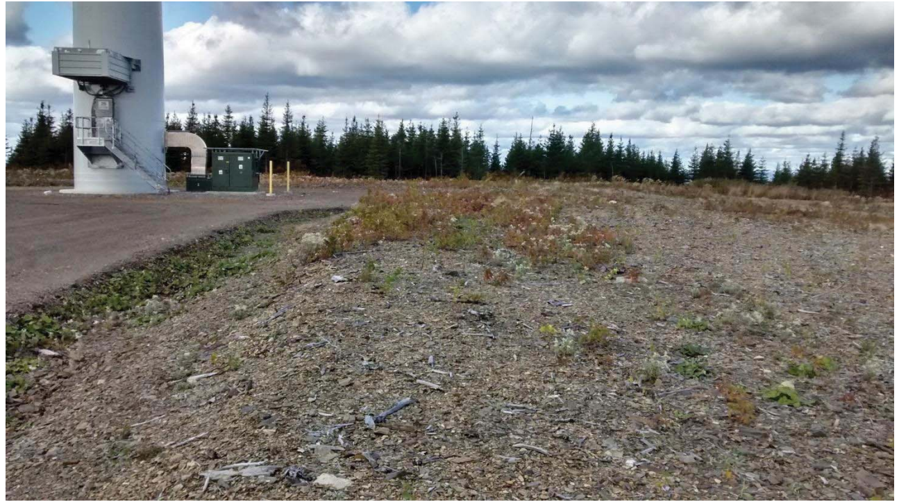
SITE : Éolienne 25 PROPORTION COUVERTE : 100 %
