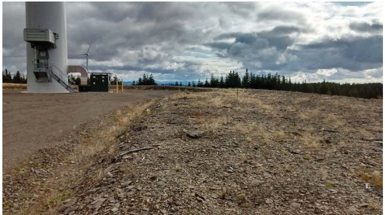
SITE : Éolienne 13 PROPORTION COUVERTE : 98 %
