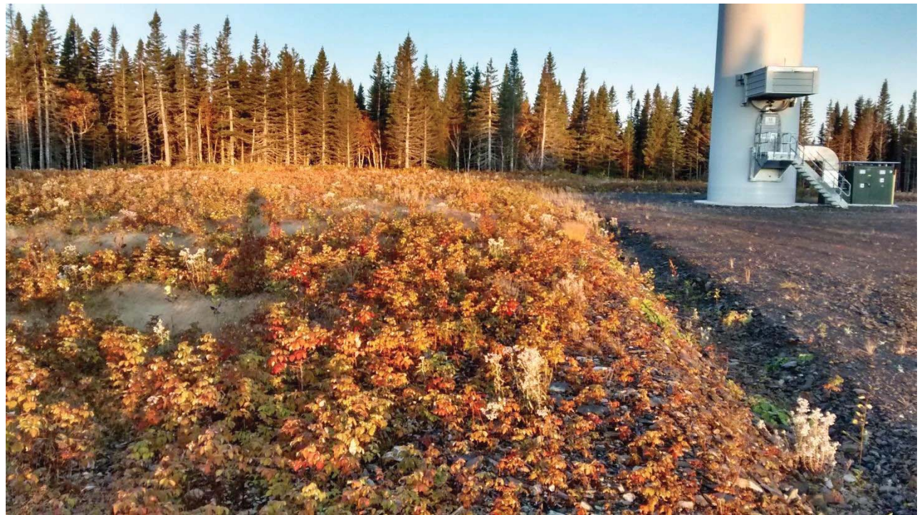
SITE : Éolienne 16 PROPORTION COUVERTE : 100 %
