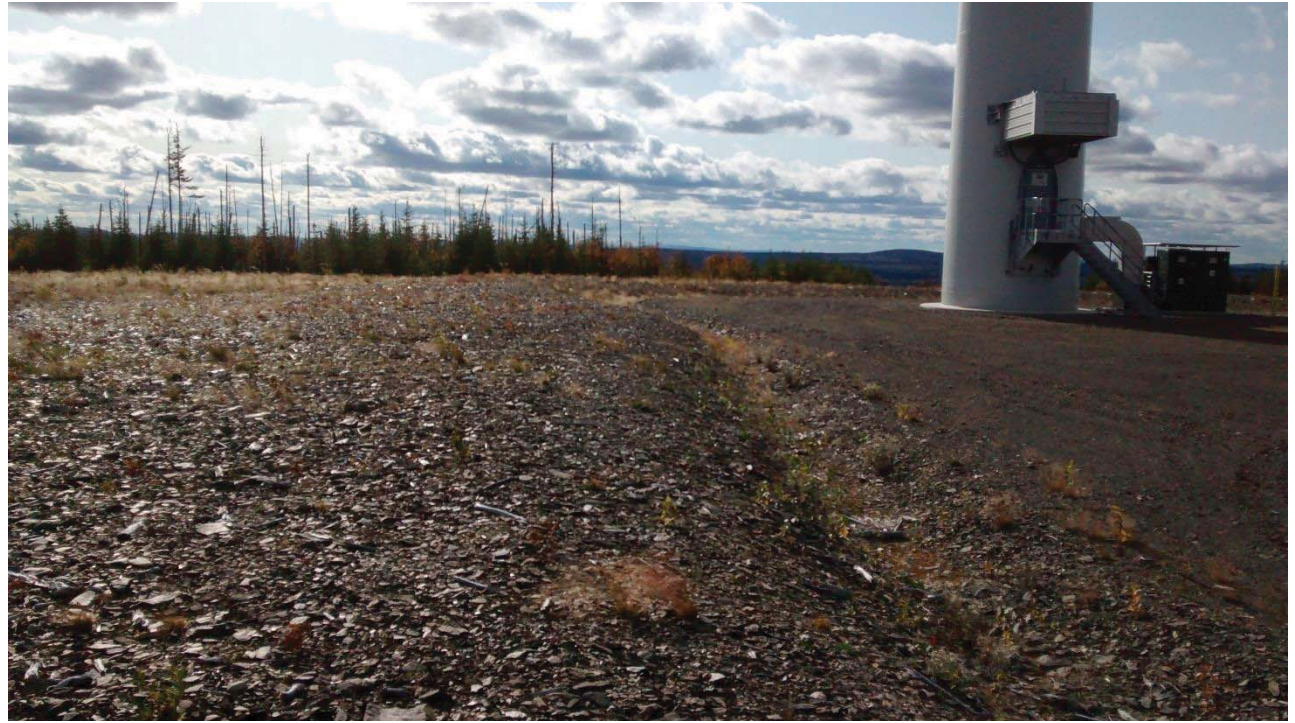
SITE : Éolienne 30 PROPORTION COUVERTE : 96 %
