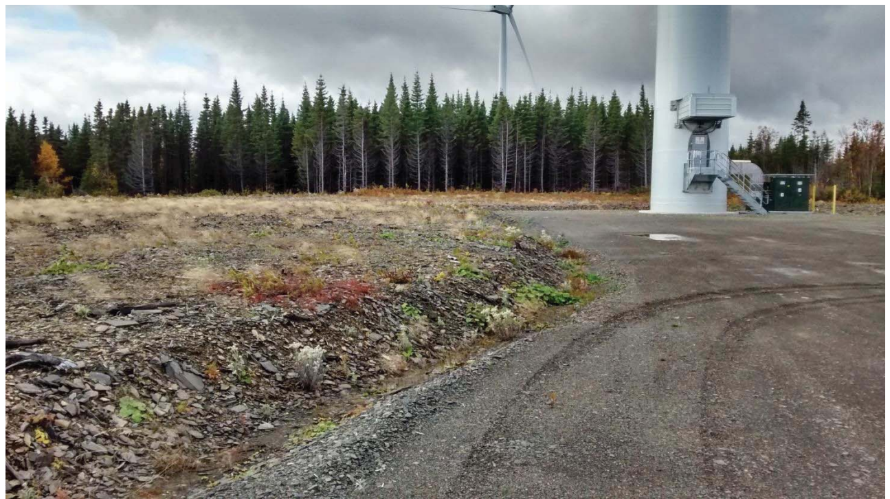
SITE : Éolienne 7 PROPORTION COUVERTE : 76 %
