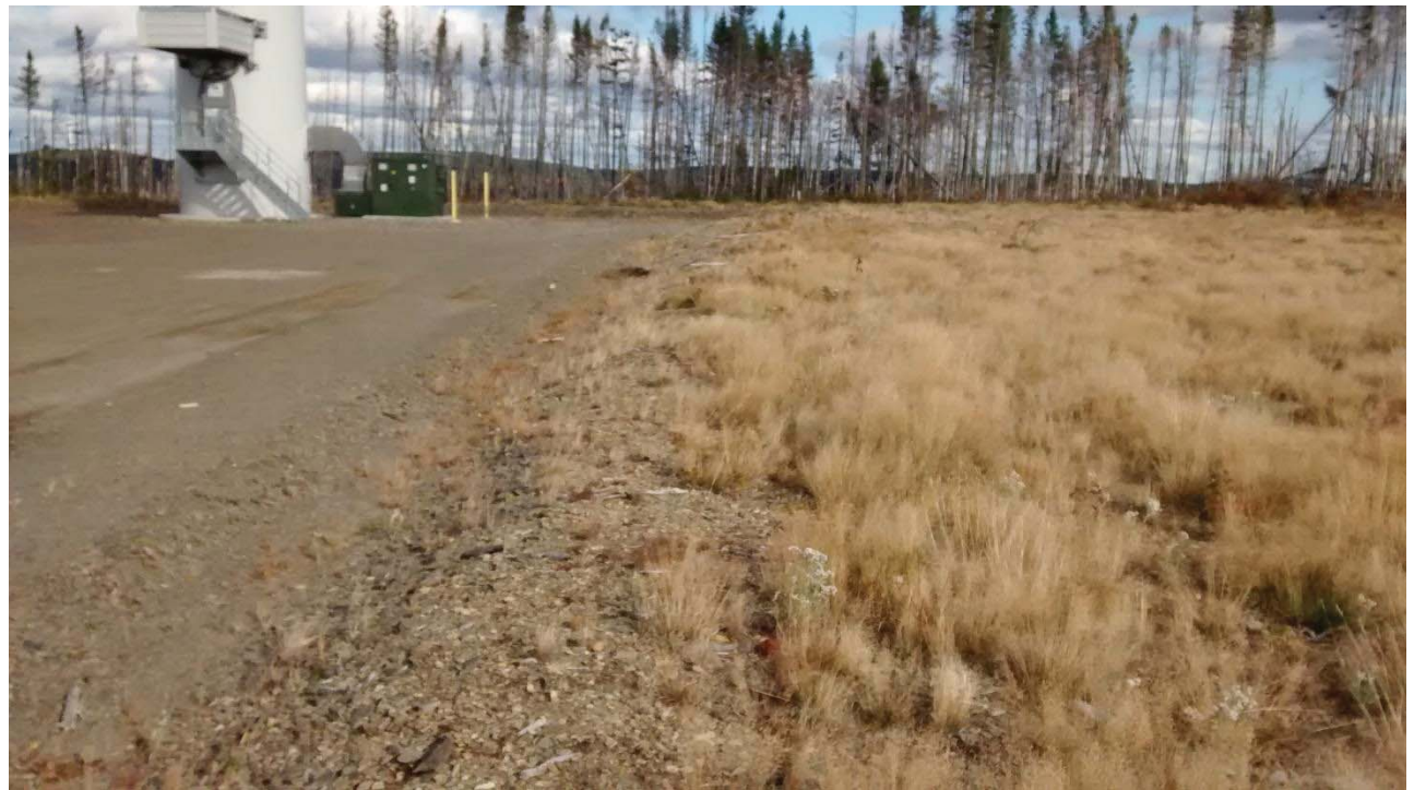
SITE : Éolienne 26 PROPORTION COUVERTE : 84 %
