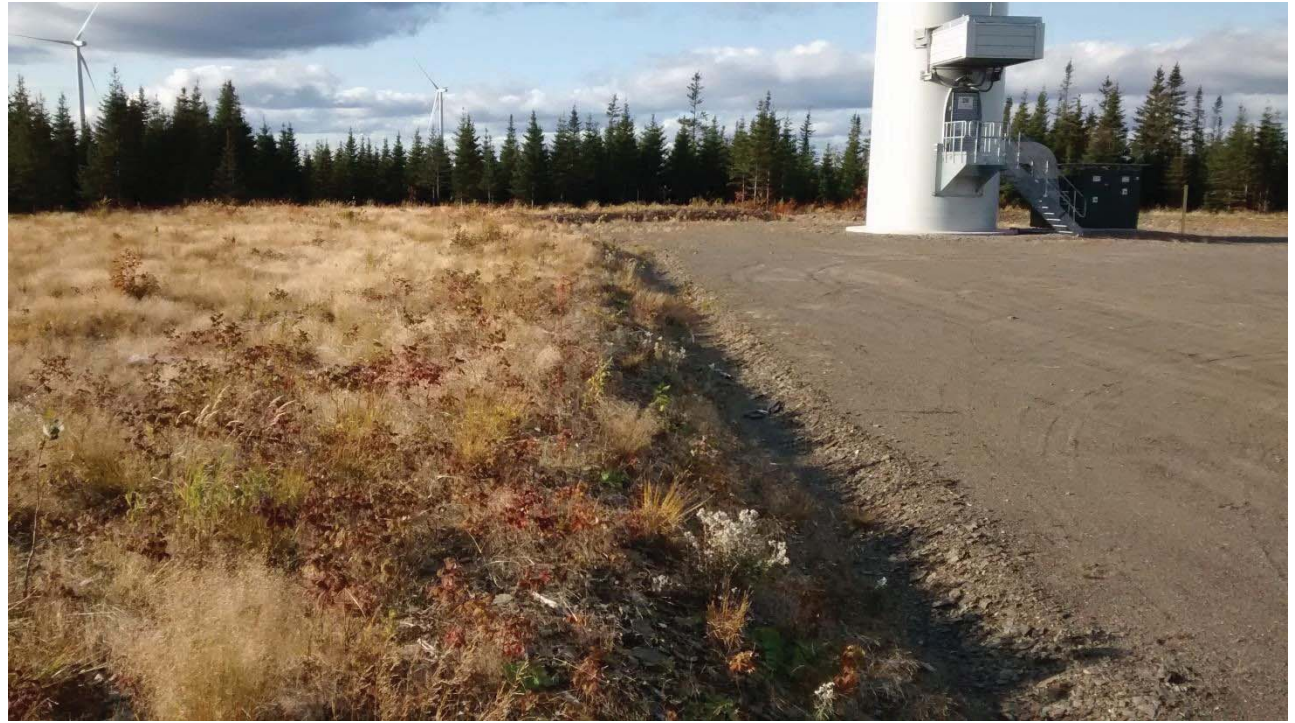
SITE : Éolienne 28 PROPORTION COUVERTE : 98 %
