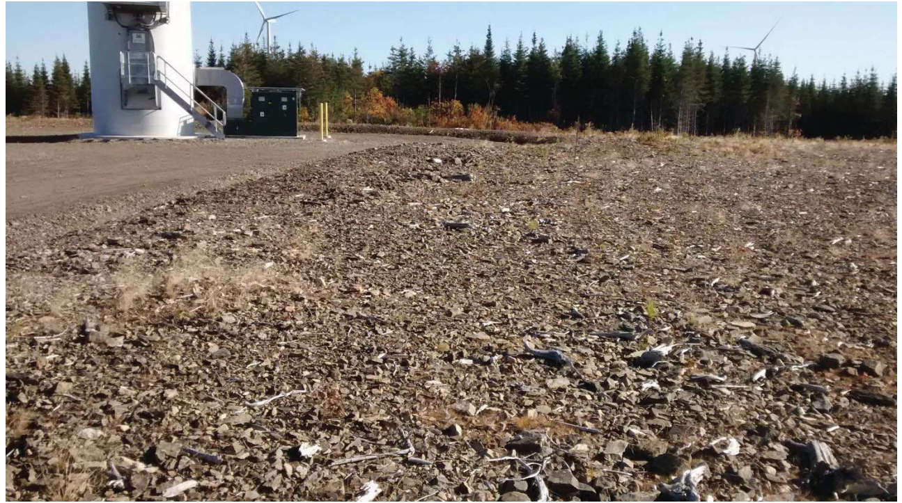
SITE : Éolienne 36 PROPORTION COUVERTE : 81 %
