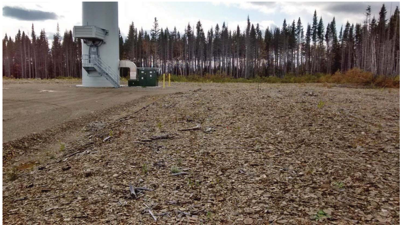
SITE : Éolienne 34 PROPORTION COUVERTE : 94 %
