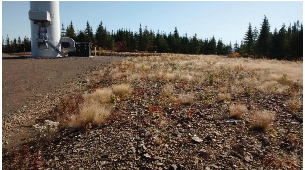
SITE : Éolienne 43 PROPORTION COUVERTE : 77 %
