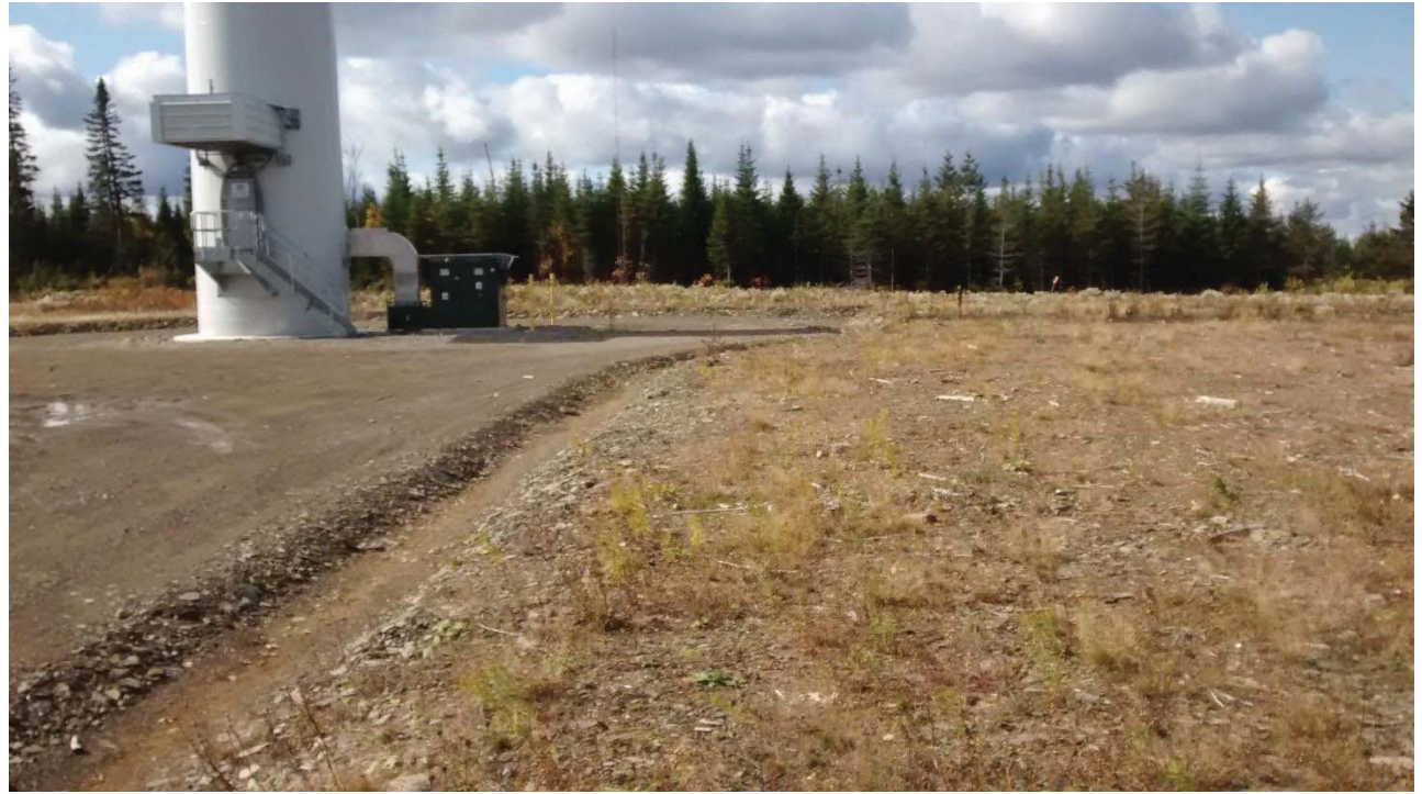
SITE : Éolienne 20 PROPORTION COUVERTE : 98 %
