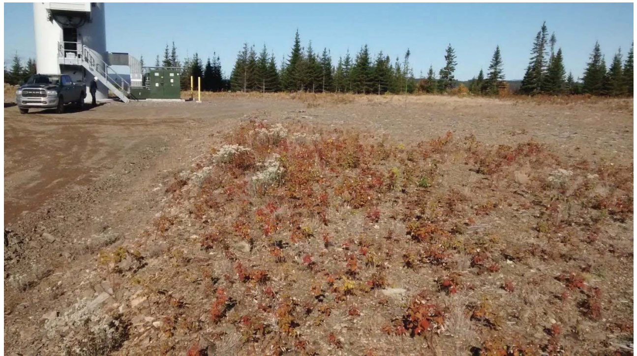
SITE : Éolienne 38 PROPORTION COUVERTE : 76 %
