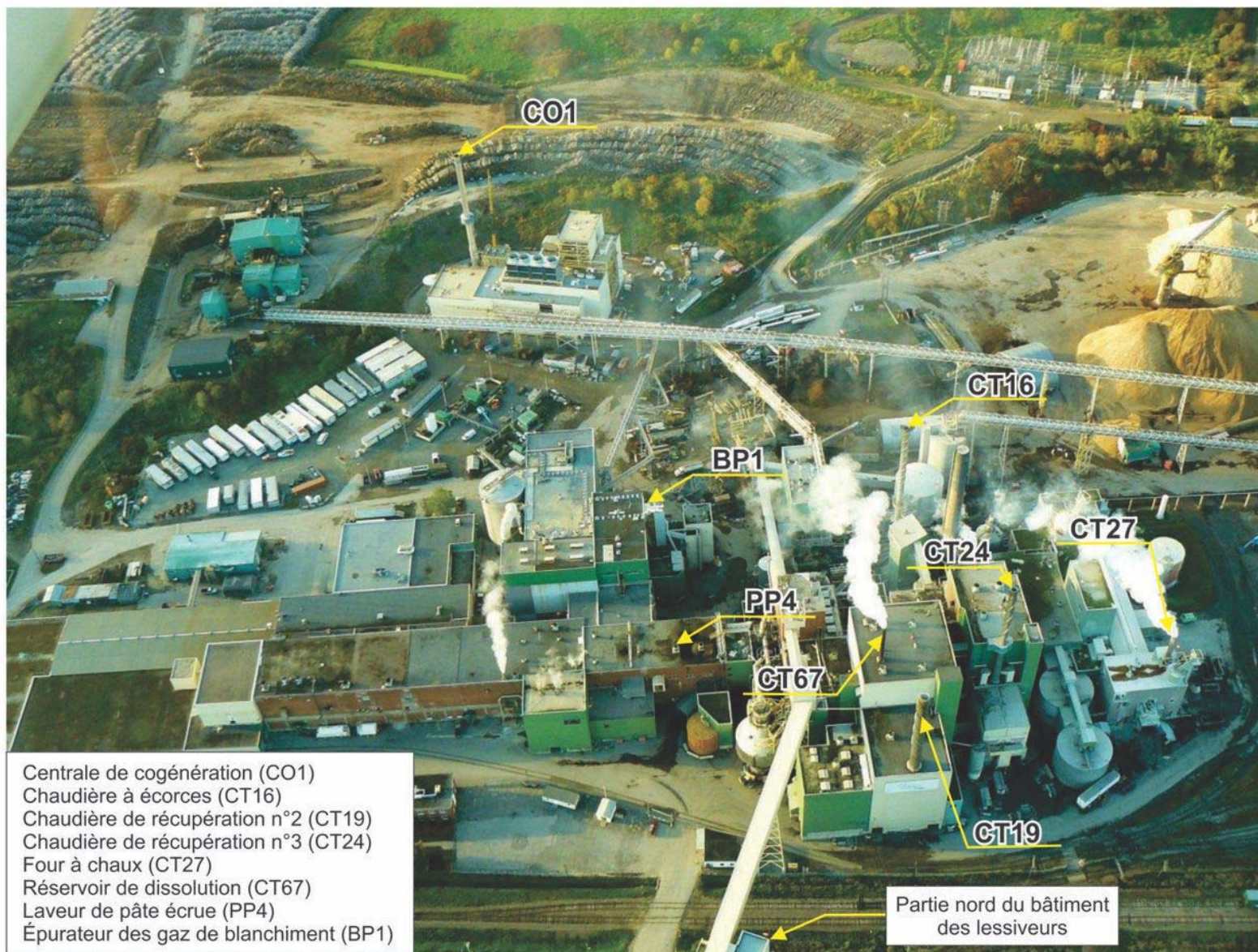
Figure 2 Photographie aérienne de l'usine de FCS à Thurso (vue du sud)
