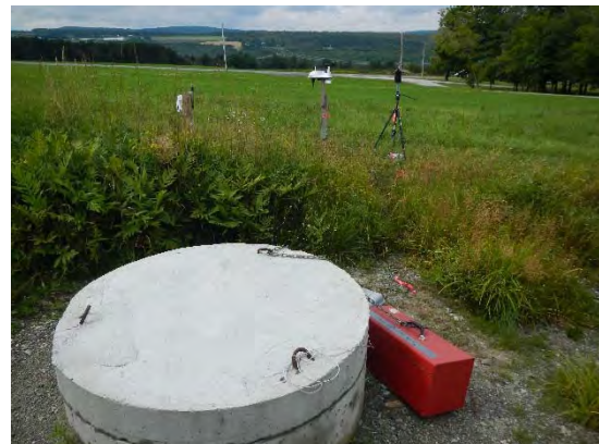
Photo 4. Vue dans la direction ouest
