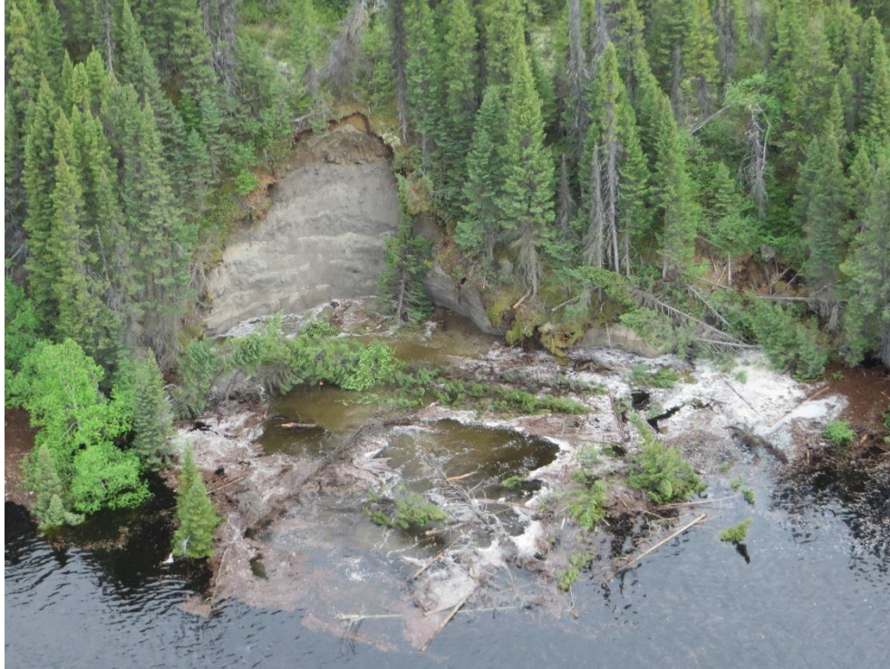
Photo 69 Zone d'érosion récente, observation E28 (PK 205/rive est), visite 2 (24-06-2020)
