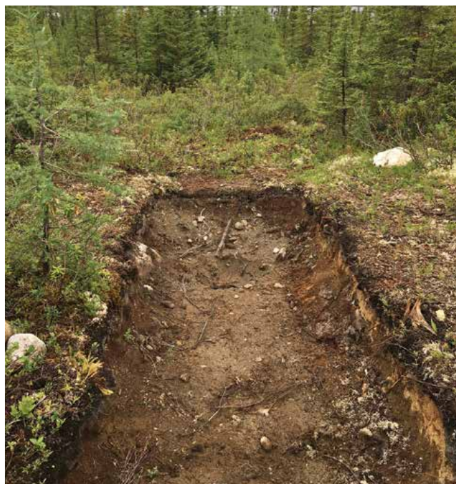
Décontamination d'une ancienne cache à carburant au lac Desaulniers
