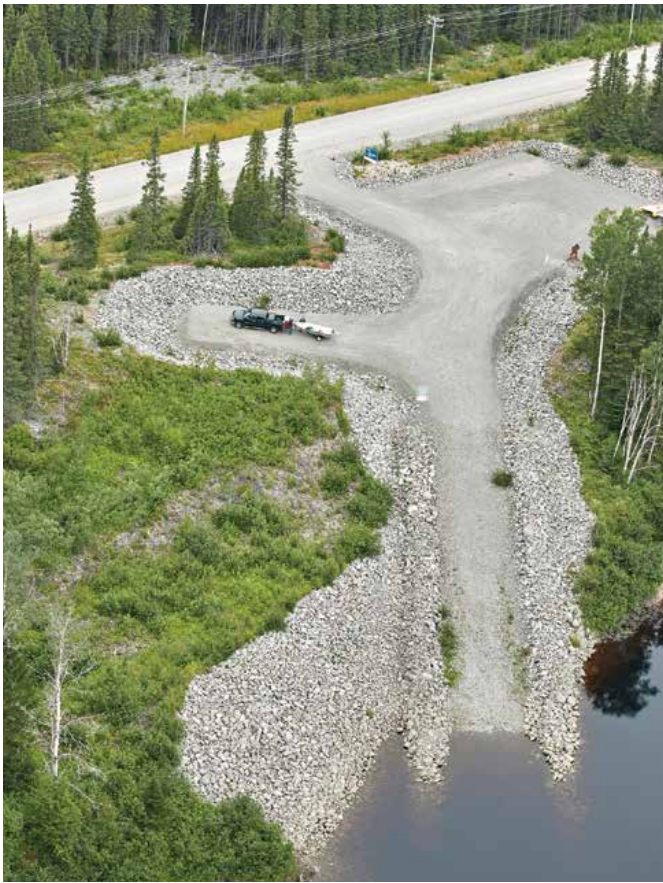
Rampe de mise à l'eau du réservoir de la Romaine 1 (kilomètre 32 de la route de la Romaine)
