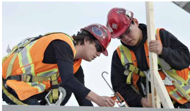
Des employés d'une entreprise d'Ekuanitshit effectuent des travaux au campement du Mista
