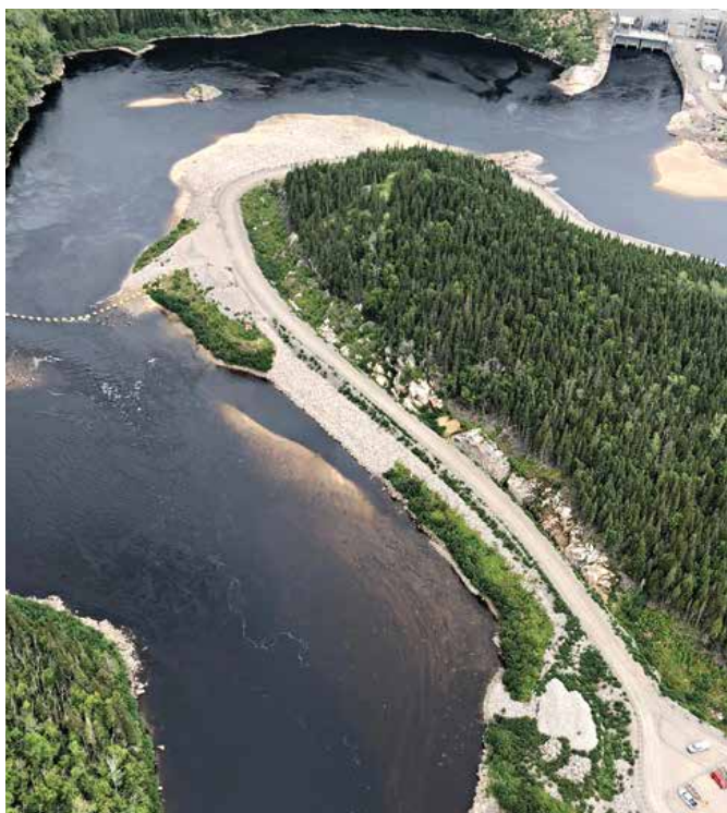
Ensablement de l'aire d'alevinage aménagée au PK 51 de la Romaine
