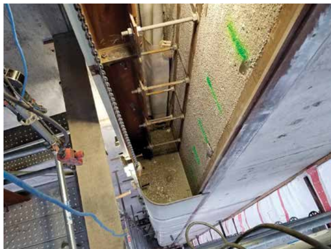
Les travaux de bétonnage, comme celui des guides de la prise d'eau de la Romaine-4, sont aussi une source de GES
