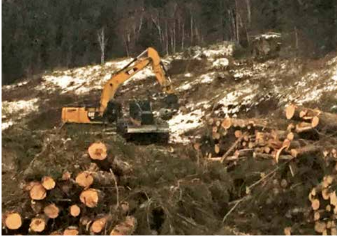
Ramassage des débris ligneux dans l'aire d'enneigement du réservoir de la Romaine 4 à l'aide d'une pelle hydraulique
