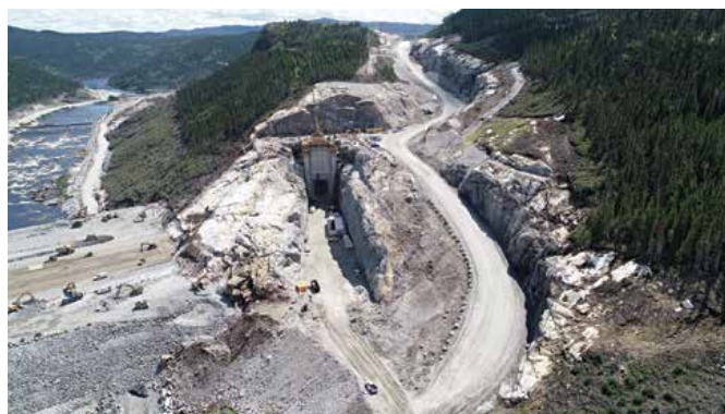
Bétonnage de la prise d'eau de la Romaine-4
