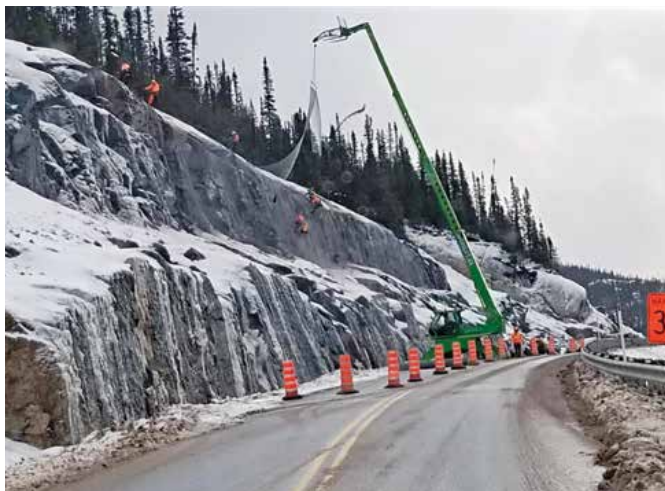
Consolidation de la paroi rocheuse au kilomètre 128 de la route de la Romaine
