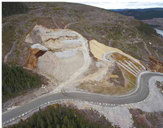
Aire de stockage de matériaux
