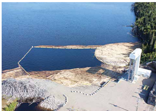
Débris ligneux flottants accumulés à la prise d'eau de la centrale de la Romaine-2
