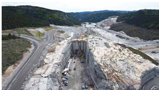
Bétonnage de l'évacuateur de crues et poursuite de la construction du barrage (à droite)
