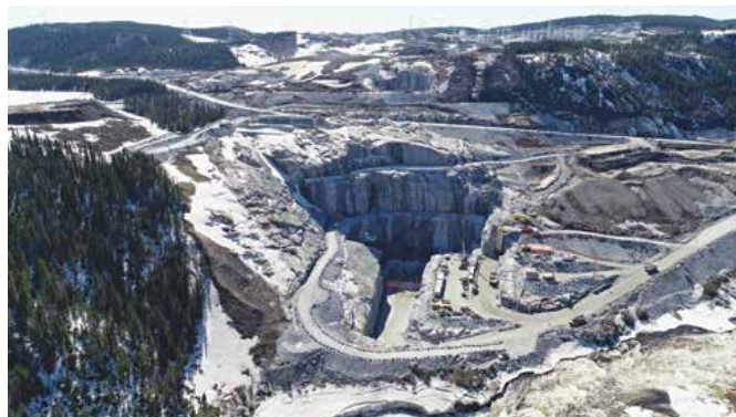
Travaux d'excavation à l'emplacement de la centrale de la Romaine-4
