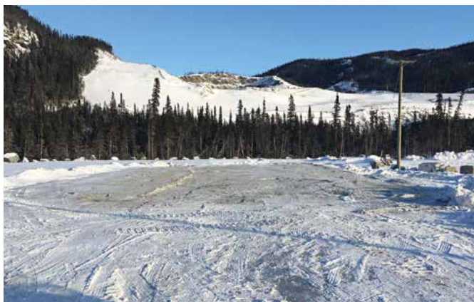
Remise en état d'une aire d'entrepreneurs à l'aménagement de la Romaine-3 en prévision de sa revégétalisation
