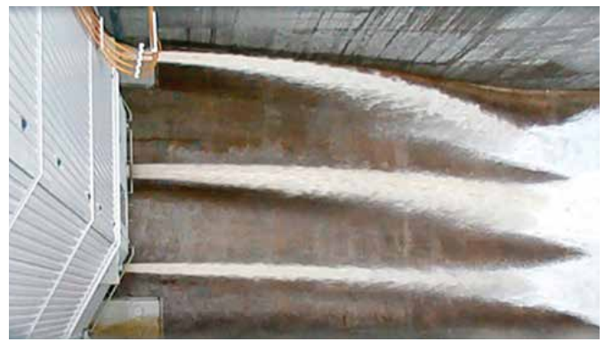
Vannettes d'une des vannes de l'évacuateur de crues de la Romaine-2 assurant le débit réservé en aval
