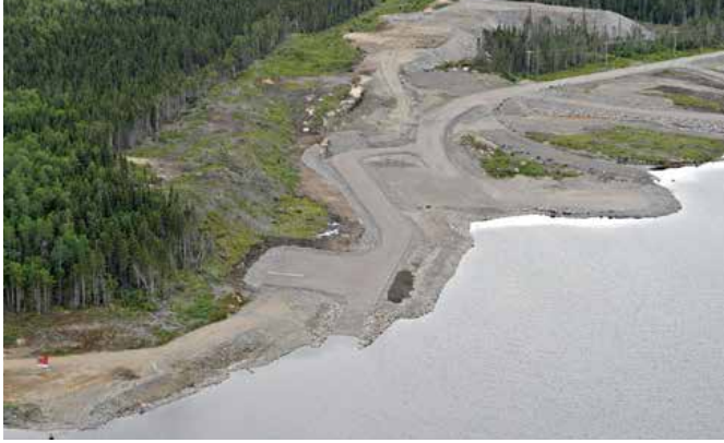
Rampe de mise à l'eau amont du réservoir de la Romaine 1 (accès depuis le kilomètre 8,9 de la route de la Romaine)
