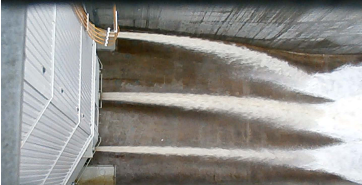
Photo 1 : Vannettes assurant le débit réservé dans une vanne de l'évacuateur de crue de la Romaine-2
