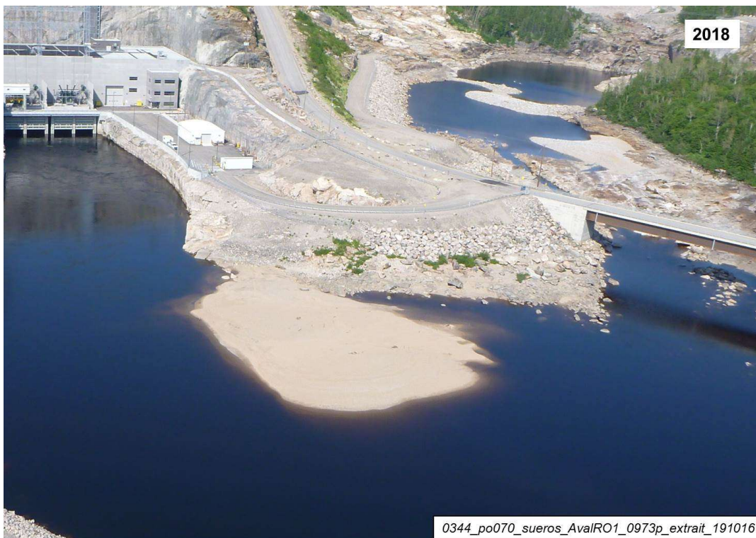
Photos 31 et 32: Photos comparatives du banc qui s'est formé sur la rive droite, à la sortie de la centrale (PK 51,5). La forme générale de ce banc semble avoir peu changé depuis 2015. Il est possible qu'un léger surcreusement se soit produit à la bordure amont du banc (illustré par la lettre A sur la photo 28).
