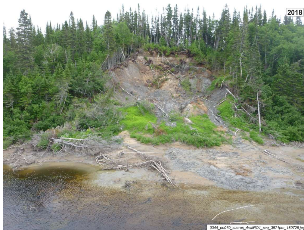
Photo 4: Dans la zone homogène 2, les hauts talus argileux situés sur la rive gauche, en amont du PK ~11,5, sont toujours considérés en érosion en 2018, mais on y signale que très peu de changements. Le seul nouveau glissement survenu depuis 2015 se trouve au PK 13,3 (montré sur la photo).
