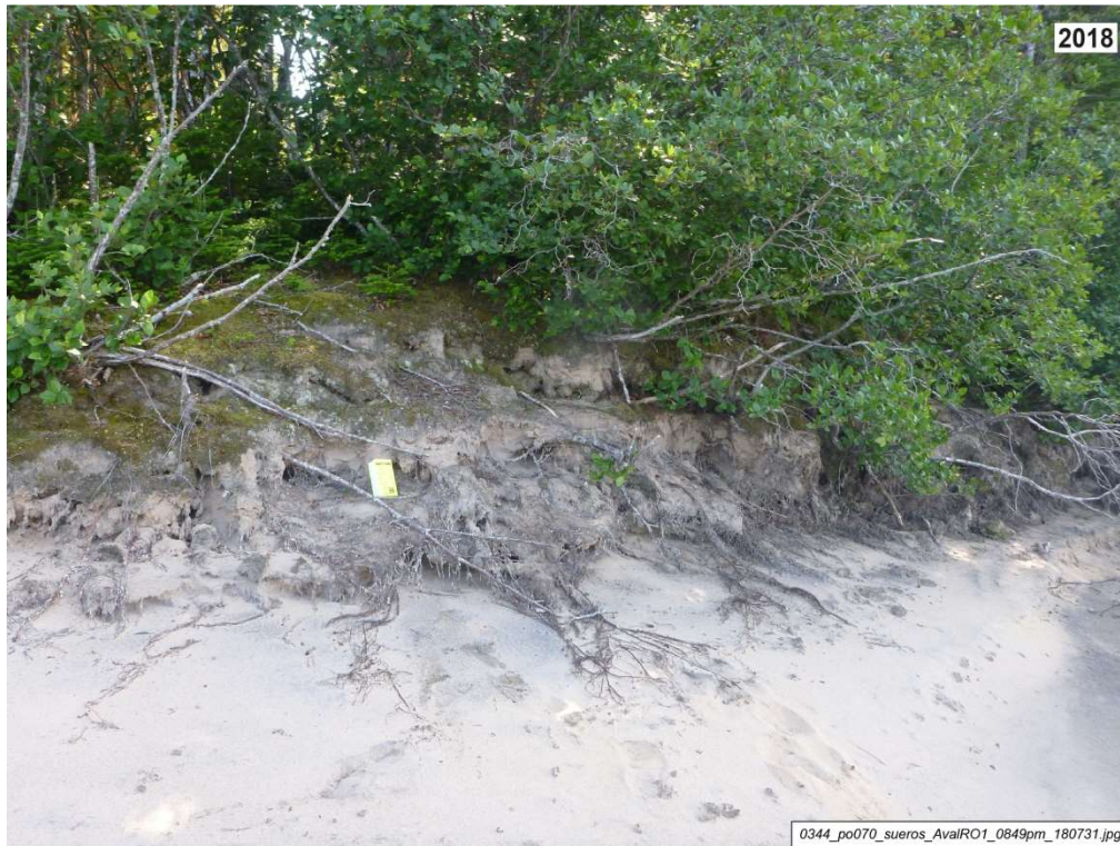
Photo 12: En amont du PK 25, seul un court segment de la rive gauche (montré ici, vers le PK 25,5) semble avoir été déstabilisé depuis 2015. Les autres rives de ce tronçon de rivière sont pour la plupart considérés stables ou en voie de le devenir.
