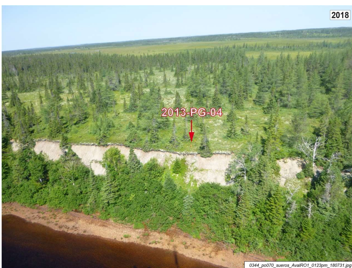
Photo A4-14 à A4-16: Station témoin 2013-PG-04, rive droite PK 41,3. La station 2013-PG-04 se trouve sur une terrasse de sable graveleux bordée d'un talus d'une dizaine de mètres de hauteur. Le profil du talus n'a pas changé depuis 2013 et le pied du versant ne semble plus rejoint par la rivière. Bien que la portion supérieure du talus demeure partiellement dénudée, sa base est colonisée par une végétation arbustive et arborescente dense. Cette rive est désormais considérée stable.
