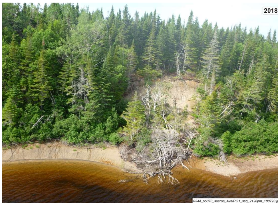
Photo 16: Malgré la tendance générale à la stabilisation dans la zone 5, de courts segments de rive dispersés entre les PK 35 et 43 ont été érodés depuis 2015, par sapement et éboulements. La photo montre un éboulement survenu récemment sur la rive droite, vers le PK 39,7.
