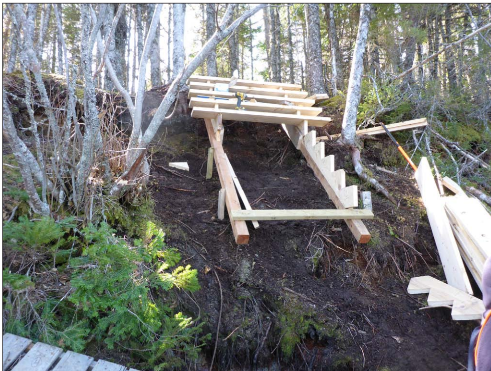
Photo 14 – Installation de l’escalier en rive.
