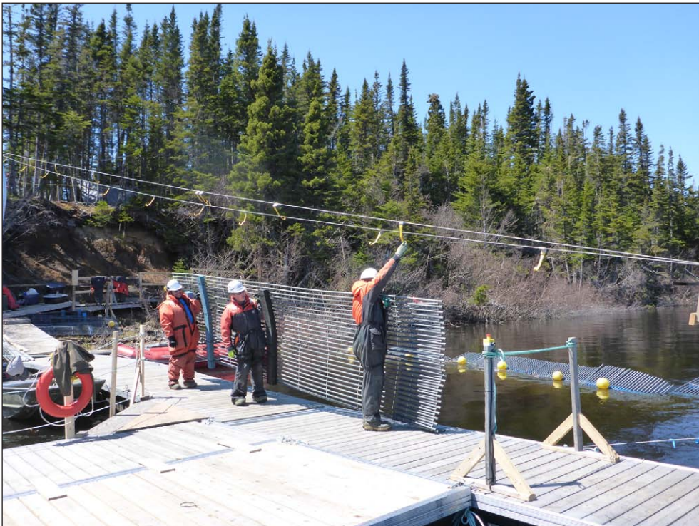
Photo 18 – Installation de la barrière de comptage dans la Romaine.
