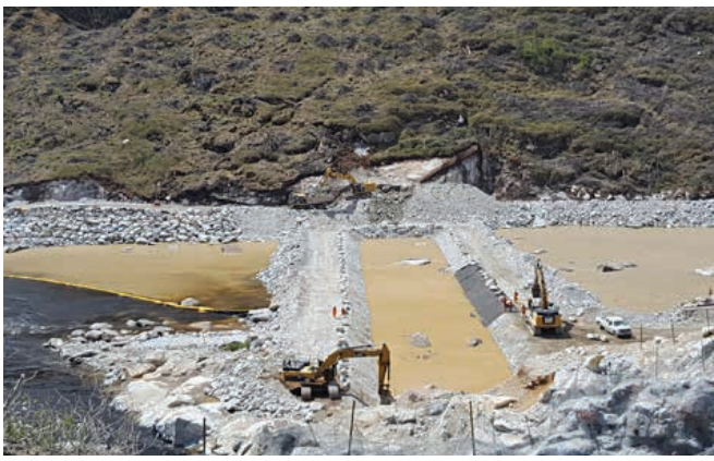
Mise en place d'un géotextile sur la paroi amont du batardeau en aval du barrage de la Romaine-4
