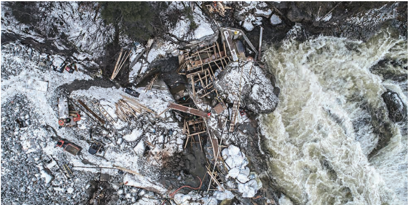
Chantier de construction de la passe migratoire de la rivière Saint-Jean
