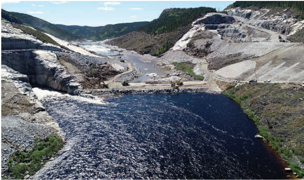
Mise en service de la dérivation provisoire et construction du prébardeau amont du barrage de la Romaine-4
