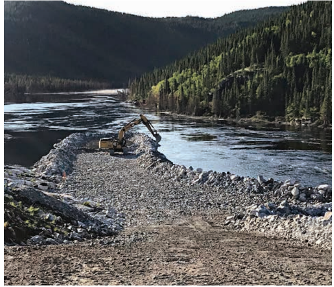
Excavation du canal de fuite de la centrale de la Romaine-4
