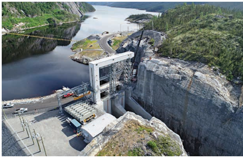
Forage des ancrages à l'évacuateur de crues de la Romaine-3
