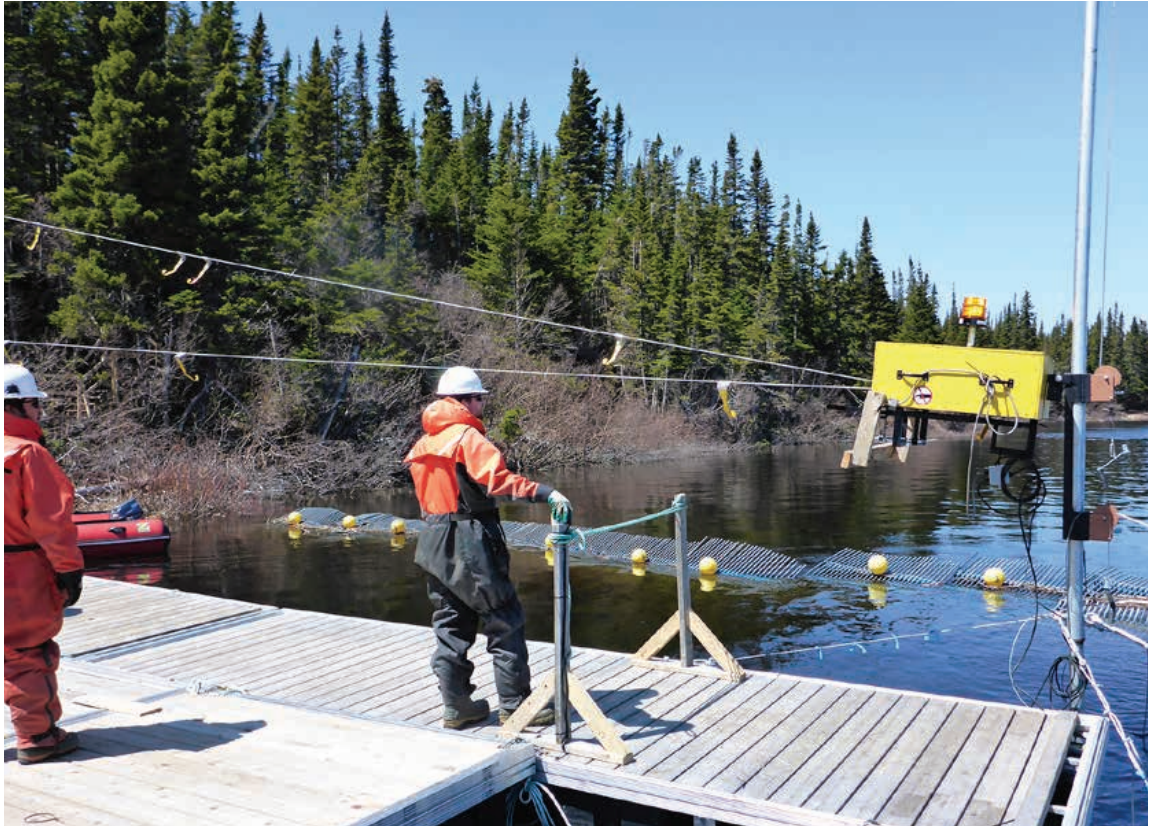
Mise en place de la barrière flottante de comptage des saumons géniteurs en montaison
