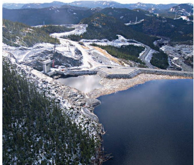
Accumulation de débris ligneux flottants à la prise d'eau de la centrale de la Romaine-3
