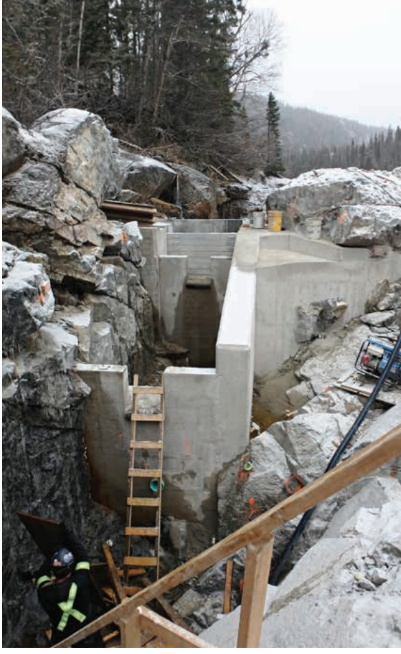
Bétonnage de la passe migratoire au PK 69,5 de la rivière Saint-Jean
