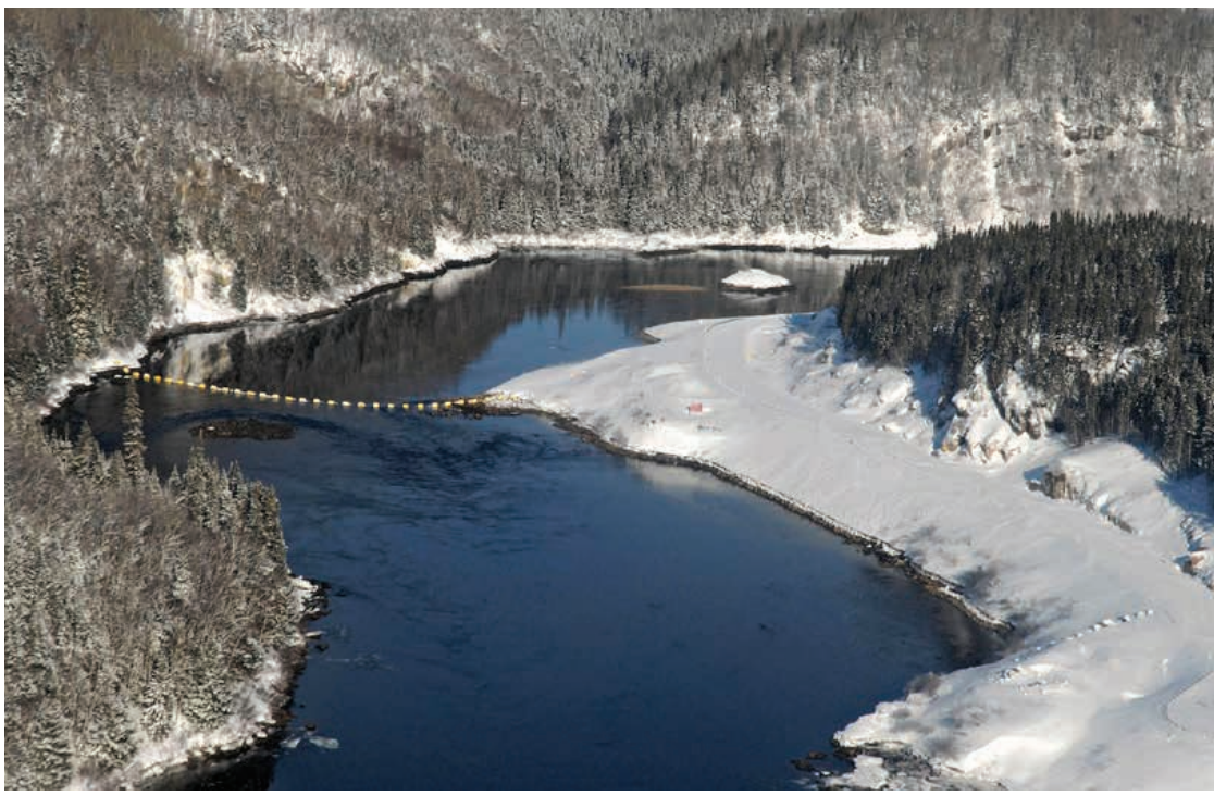
Absence de glace sur la frayère aménagée du PK 51 de la Romaine (19 janvier 2018)
