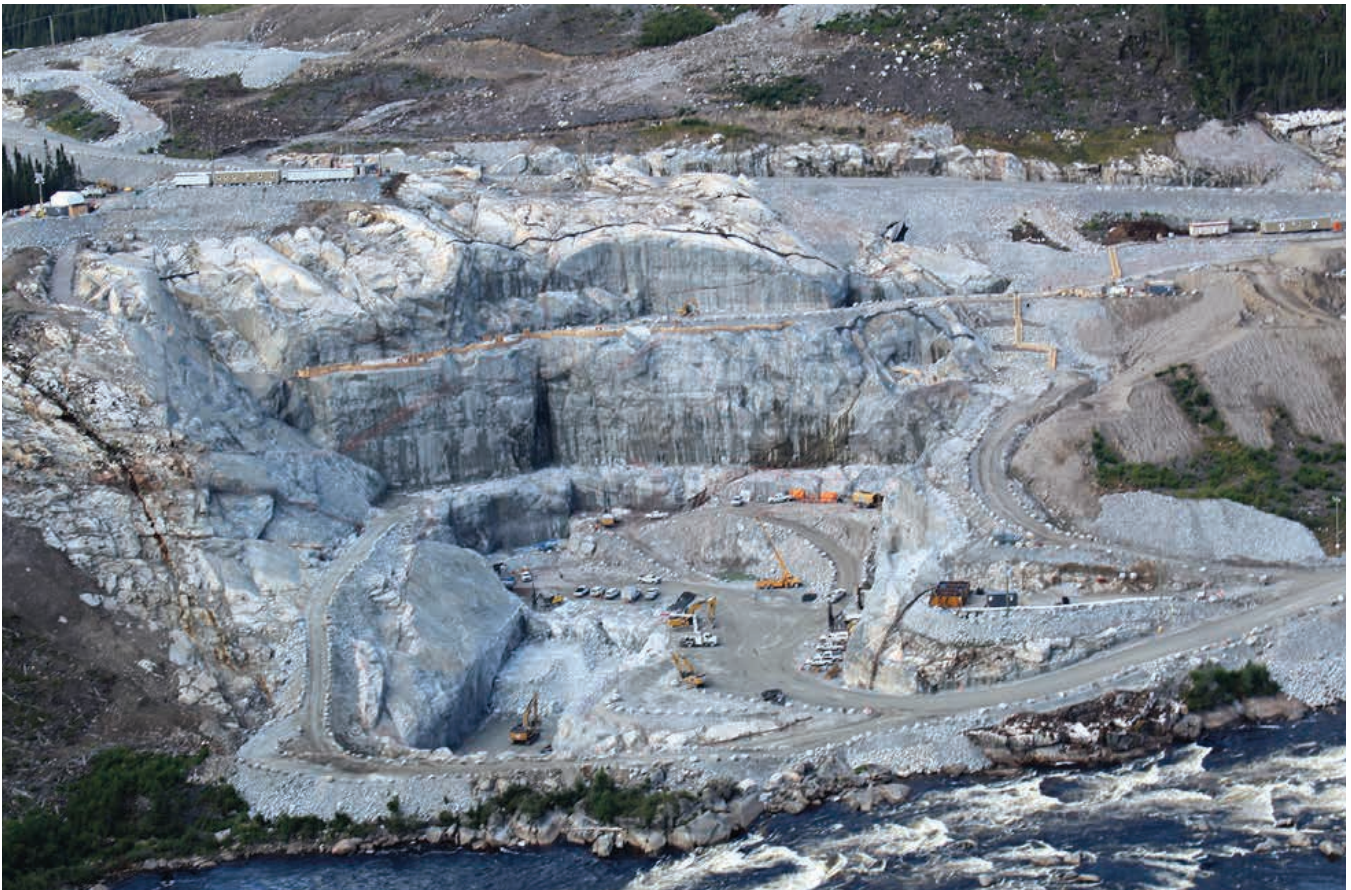
Travaux à l'emplacement de la centrale de la Romaine-4
