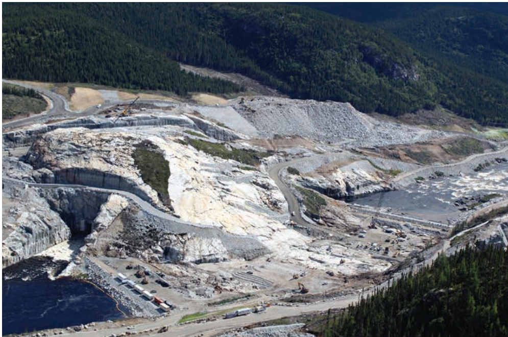
Site du barrage de la Romaine-4
