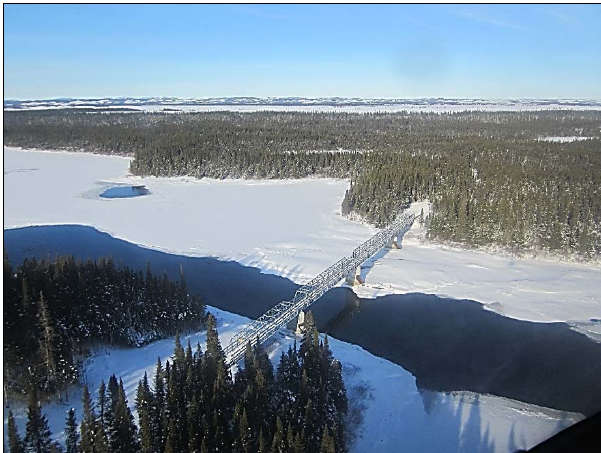
Photo 10-1 : Passerelle pour motoneige au PK 30,5 de la rivière Romaine
