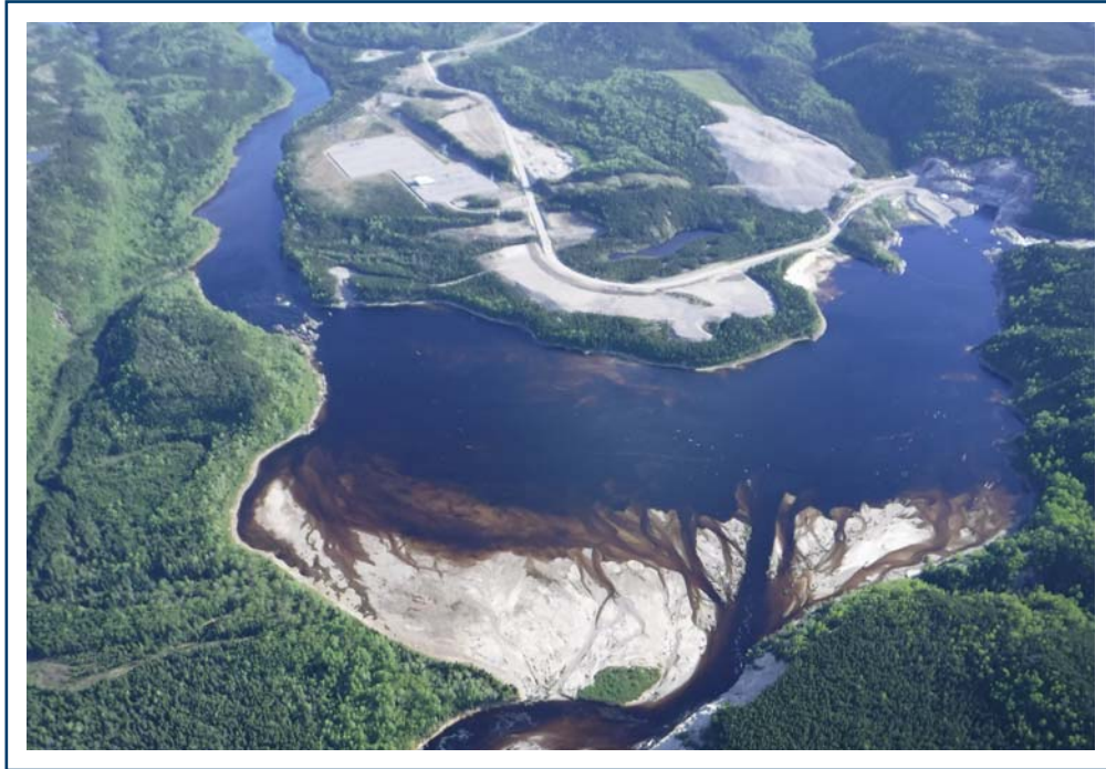
PHOTO 7 — Vue aérienne du bassin des Murailles, incluant l'embouchure de la rivière Romaine Sud-Est (en bas), la centrale de la Romaine-2 (en haut à droite) et le seuil du PK 82 du réservoir de la Romaine 1 (à gauche)
