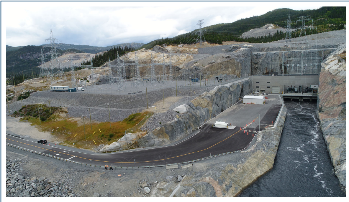
PHOTO 13 — Vue aérienne de la centrale de la Romaine-3, 14 septembre 2018
