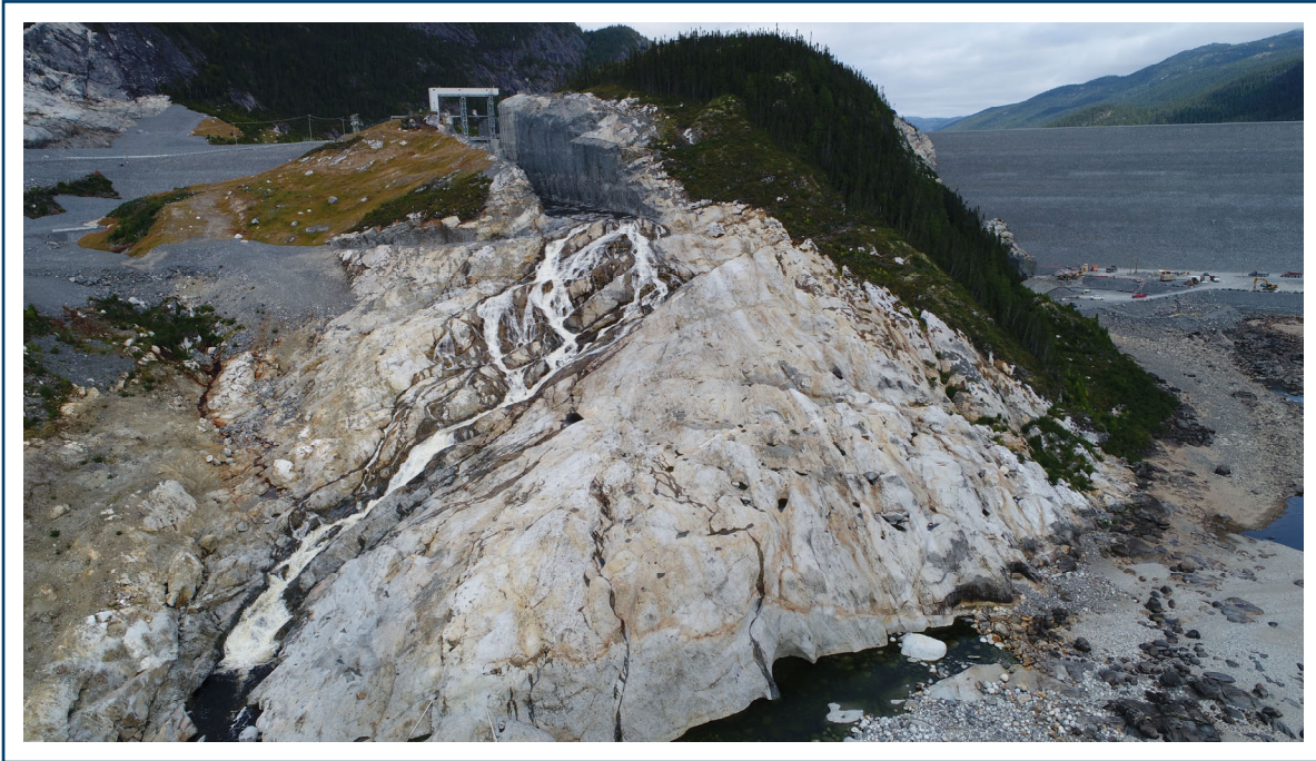
PHOTO 11 — Vue aérienne de l'évacuateur de crues et barrage (arrière-plan) de la Romaine-3, 14 septembre 2018
