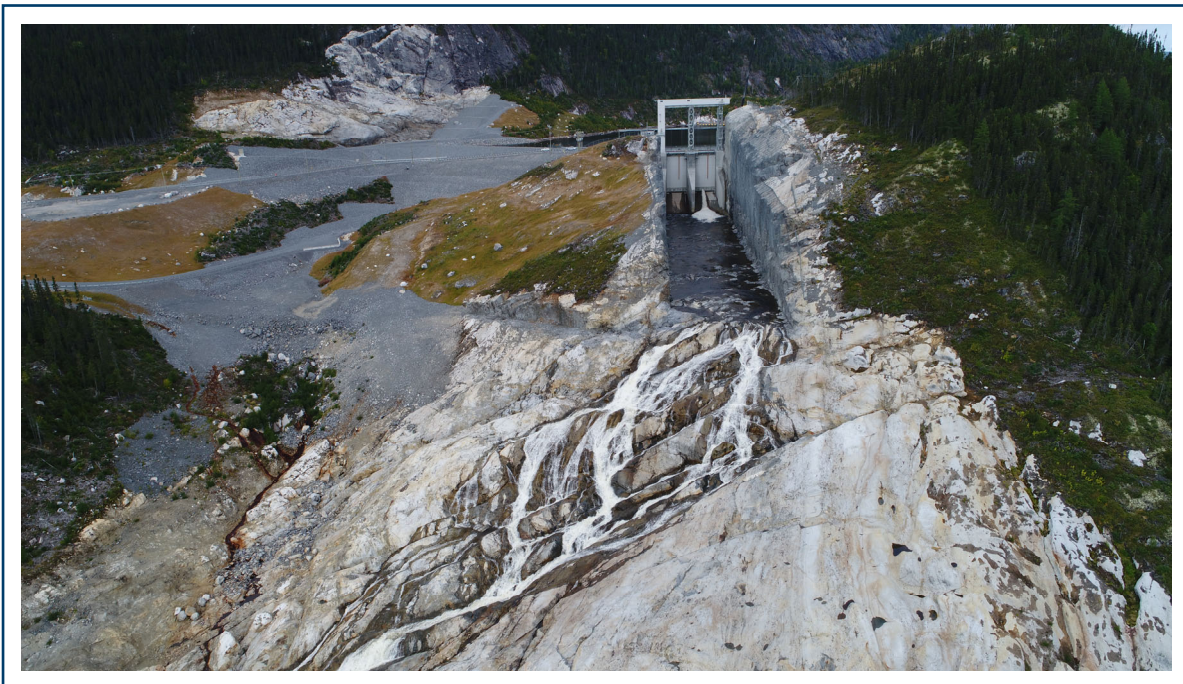
PHOTO 12 — Vue aérienne de l'évacuateur de crues de la Romaine-3 avec un débit réservé de 2,2 m 3 /s, 14 septembre 2018
