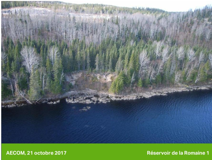
**Photo 30** Talus susceptible d'érosion localisé sur le rive ouest du réservoir de la Romaine 1 (PK 70)
