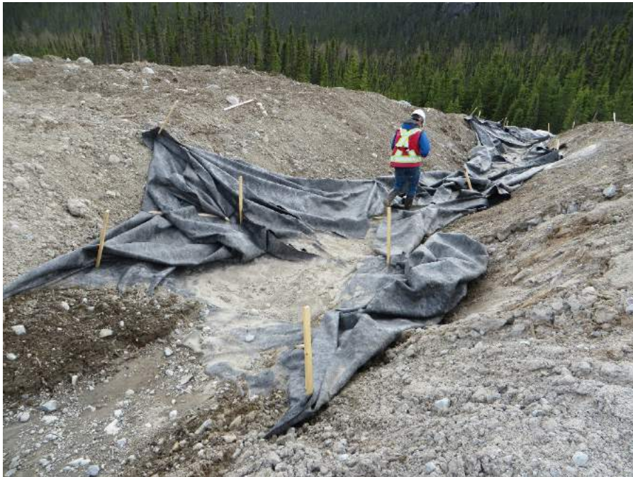
PHOTO 6 Brèche excavée – 7 juin 2018
