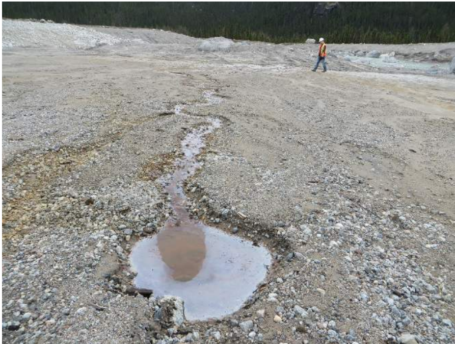
PHOTO 10 Résurgence en pied de talus côté nord – 7 juin 2018
