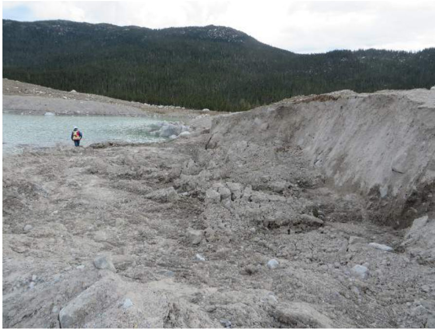
PHOTO 7 Talus instable du côté ouest – 7 juin 2018
