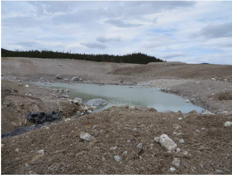
PHOTO 5 Brèche excavée à l'extrémité sud – 7 juin 2018
