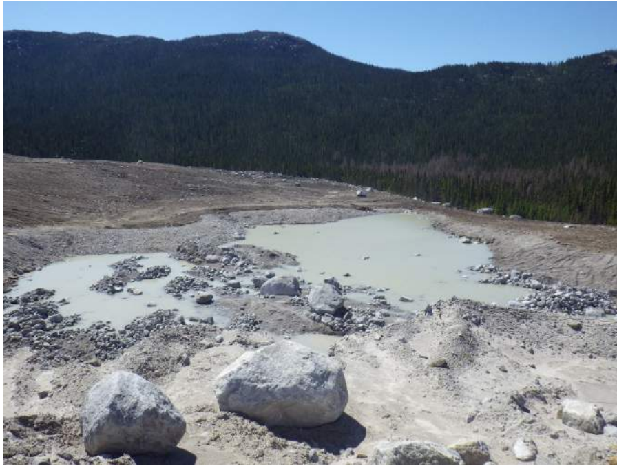
PHOTO 13 Étang du Till avant reprofilage du talus nord et haut niveau d'eau (mai 2017)
