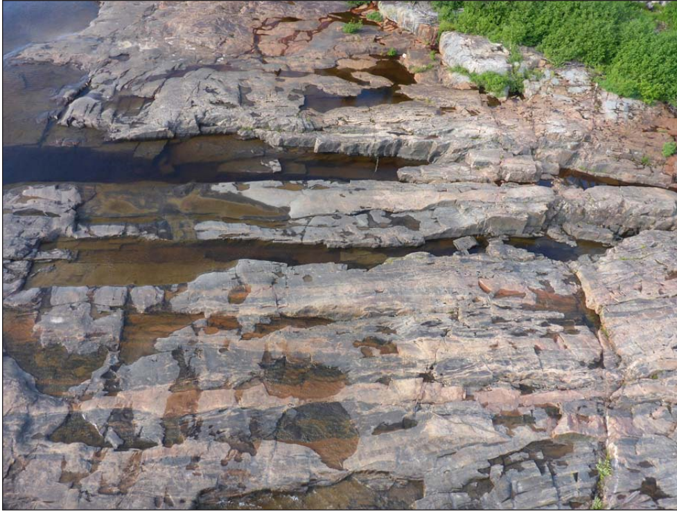
Photo 21 – Cuvettes isolées le long de la Romaine à la suite de l'arrêt d'un groupe turbine-alternateur.
