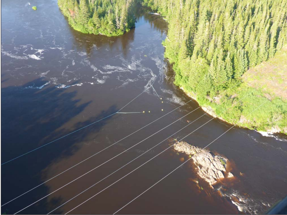
Photo 1 – Vue aérienne de la trappe 11A installée sur la Puyjalon en 2017.
