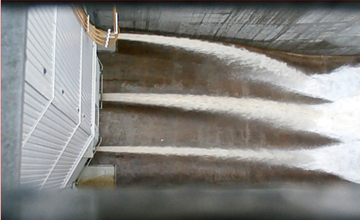
Photo 1 : Vannettes assurant le débit réservé dans une vanne de l'évacuateur de crue de la Romaine-2
