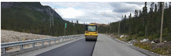
Asphaltage de la route de la Romaine entre les aménagements de la Romaine-3 et de la Romaine-4 (kilomètres 117-144)
