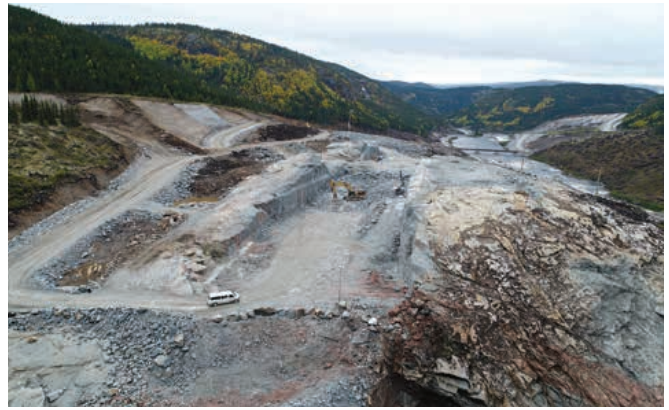
Travaux d'excavation au site de l'évacuateur de crues de la Romaine-4
