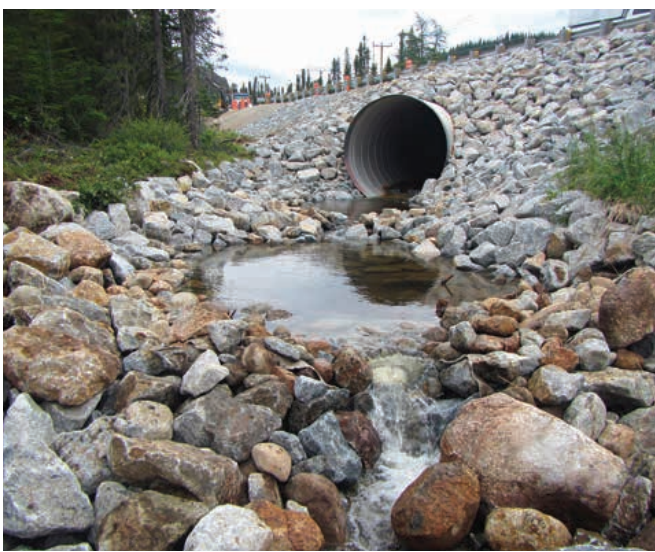
Seuils en enrochement aménagés en aval du ponceau du kilomètre 134+983
