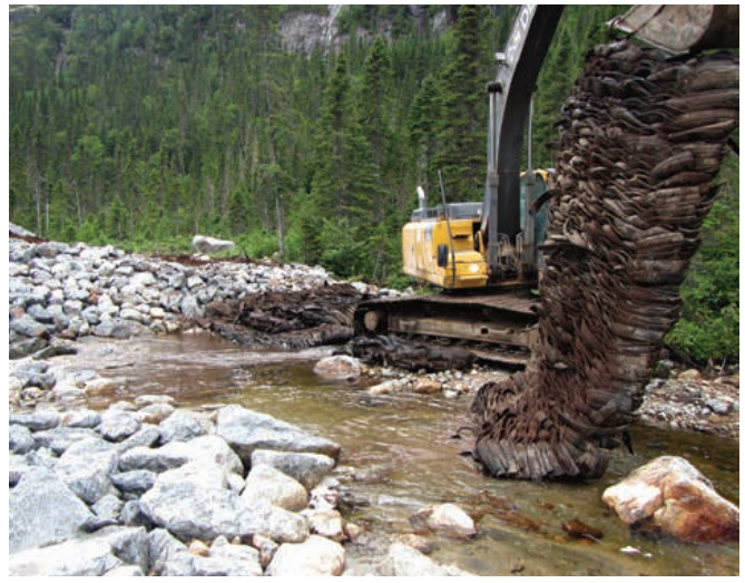
Circulation de la pelle hydraulique sur un tapis de dynamitage dans le ruisseau Mista (kilomètre 127+003)
