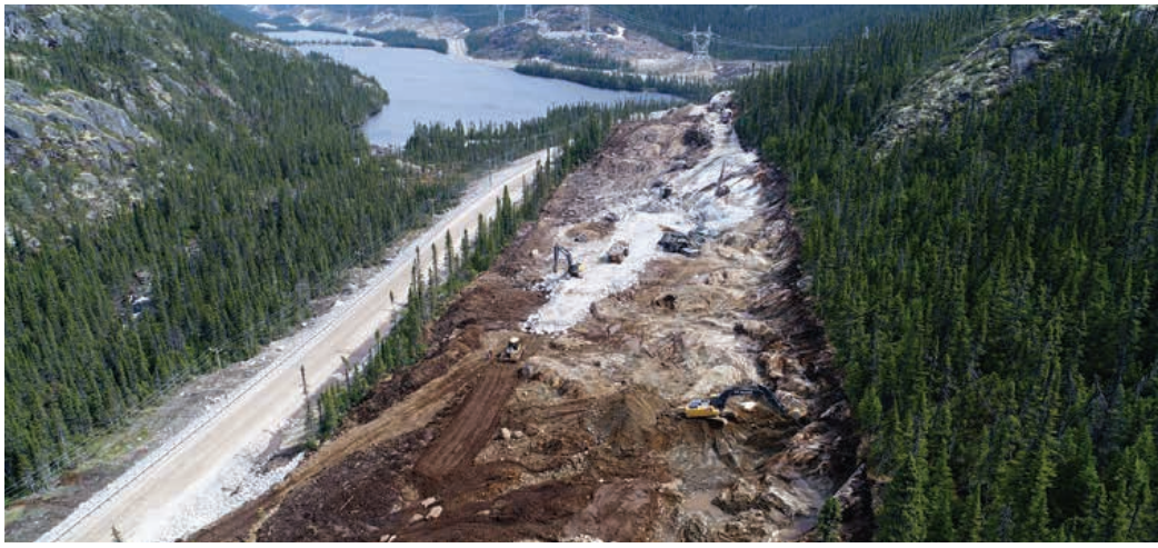
Travaux de décapage à la carrière du kilomètre 131 de la route de la Romaine
