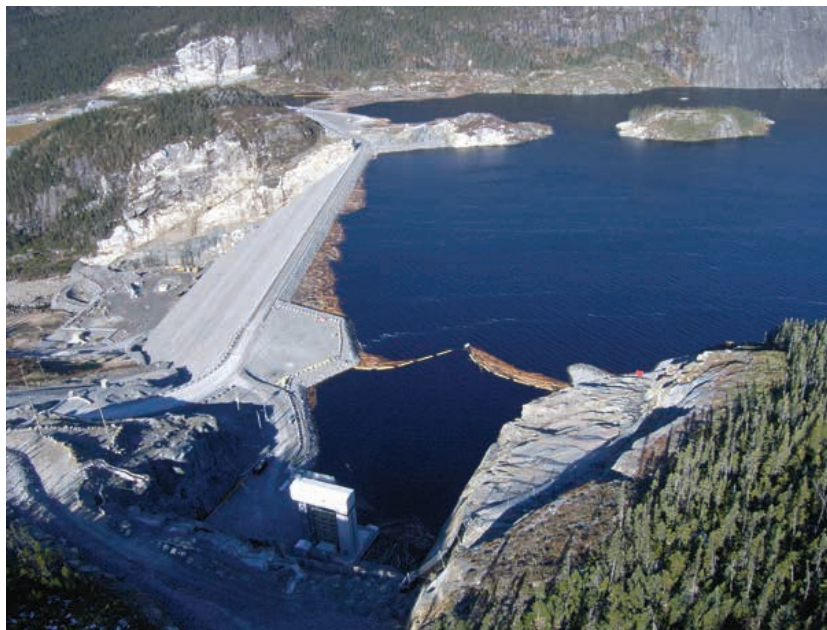
Débris ligneux à l'estacade de la prise d'eau de la Romaine-3
