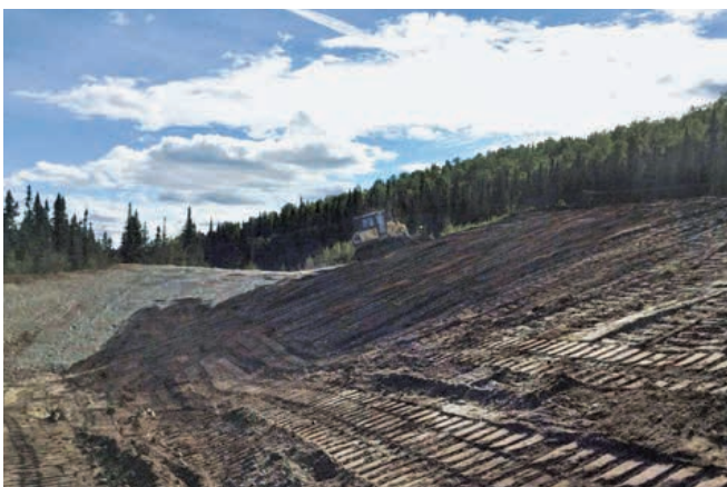
Régalage des talus d'une sablière (dépôt 5)
