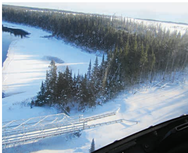
Nouvelles glissières de sécurité de la passerelle du PK 30,5 de la Romaine
