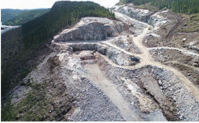
Excavation du roc à la prise d'eau de la Romaine-4
