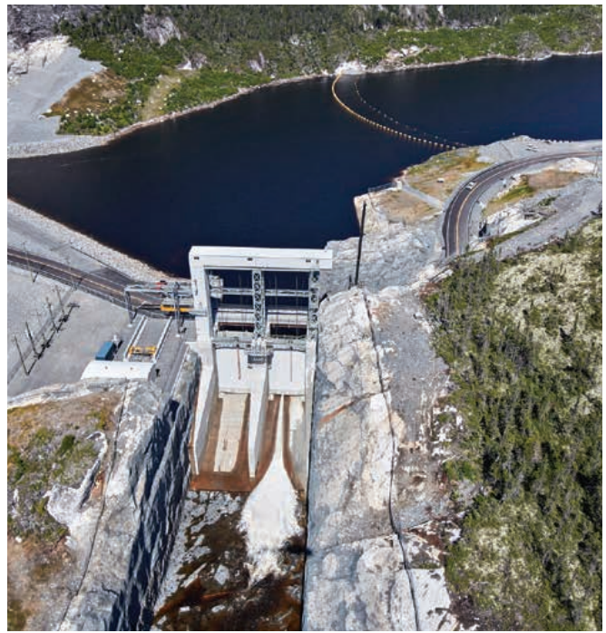
Débit réservé écologique de 2,2 m 3 /s relâché à l'évacuateur de crues de la Romaine-3
