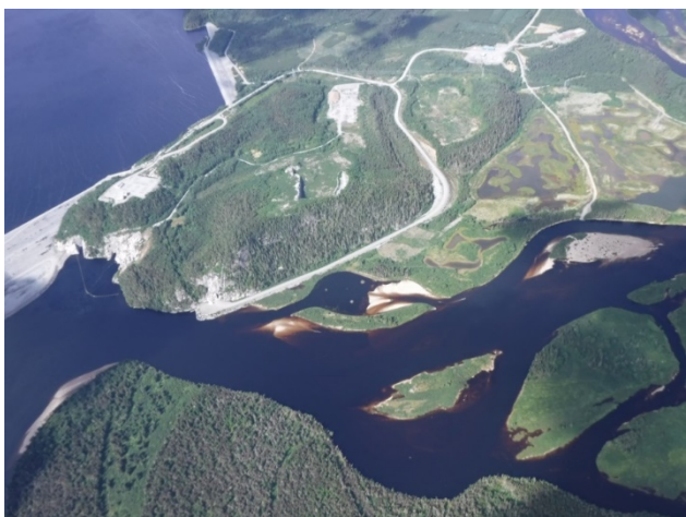
Photo 15 : Vue d'ensemble de la zone d'étude
