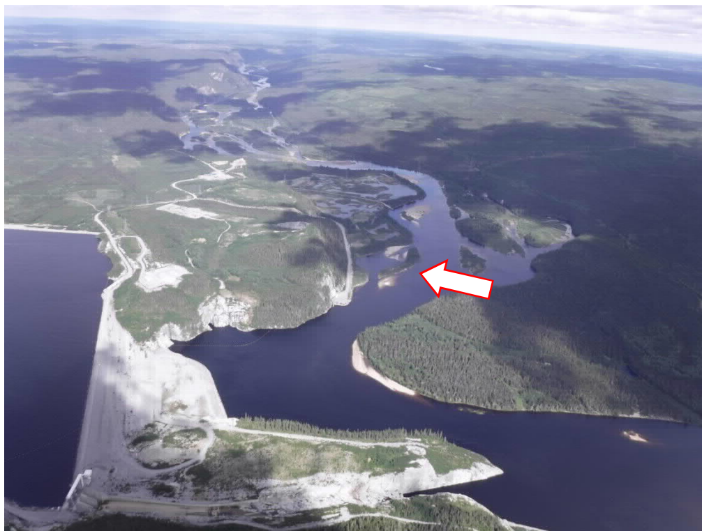
Photo 4 : Vue d'ensemble de la zone de faible pente à l’embouchure de la rivière Manouane et de l’aménagement hydroélectrique de la Péribonka.
