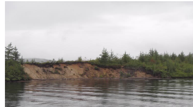
Photo 18 : Talus en érosion 2015 (AECOM 2016)
