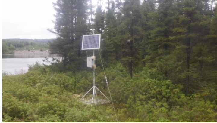
Photo 1 : Installation de la sonde satellite, en rive gauche à l'aval du pont de la Pérignonka (20 septembre 2018)
