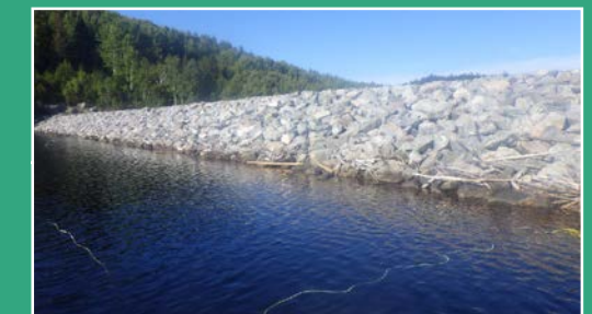
Vue de la digue B vers le nord
