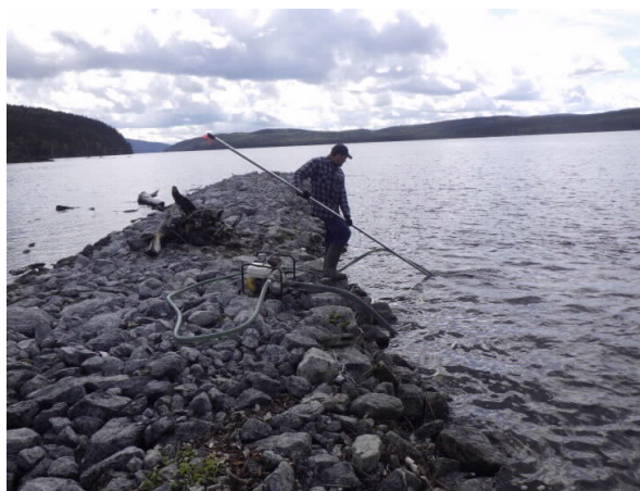
Photo 5 : Nettoyage du substrat en profondeur avec un jet d'eau à la frayère PE1697
