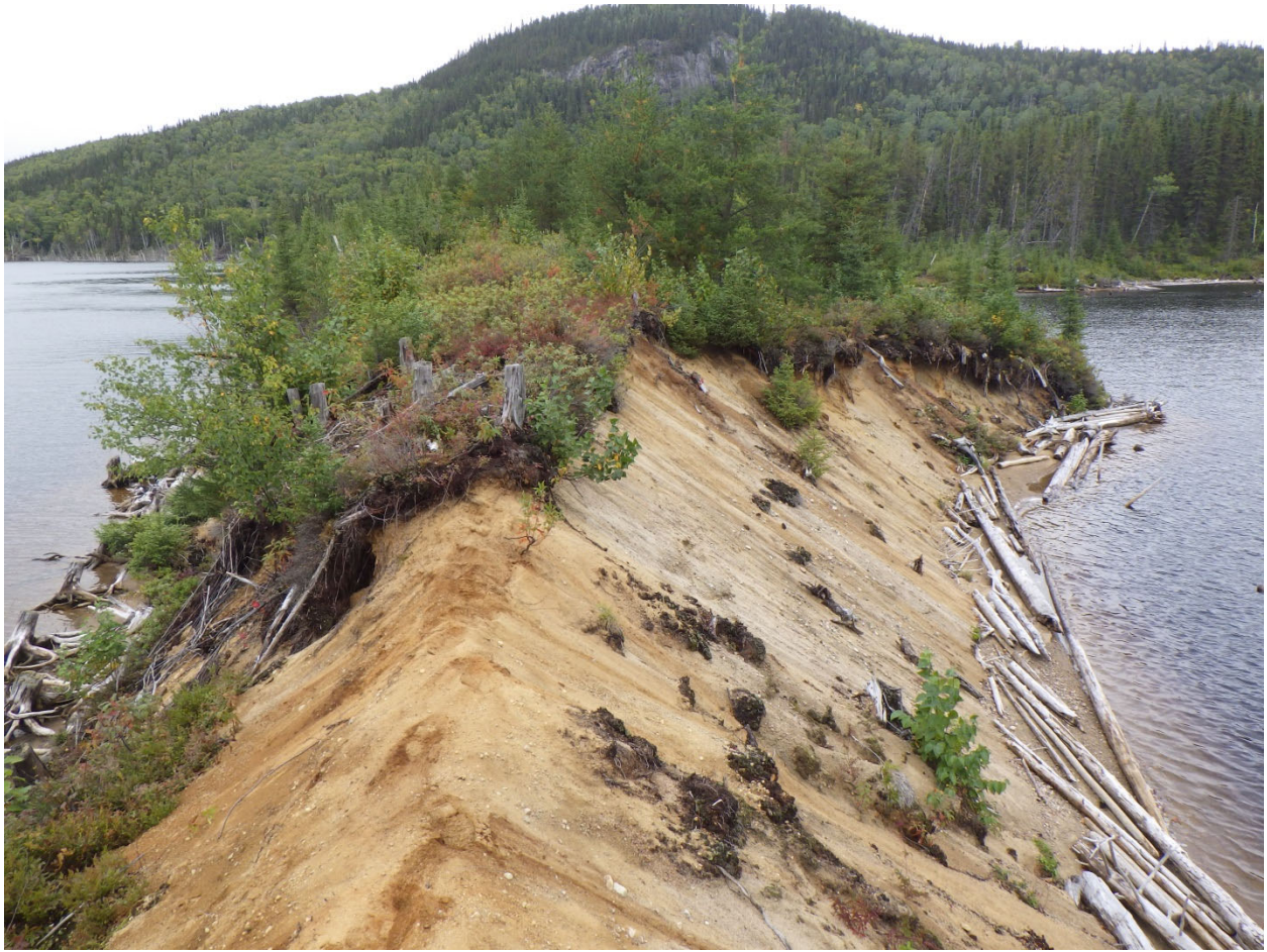
Photo 19 : Rétrécissement du talus à la frayère aménagée PE1697, septembre 2018
