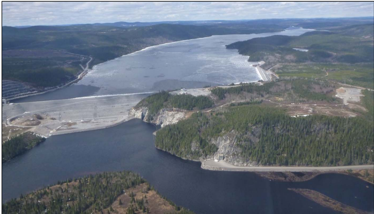
Photo 1 Étendue de la glace sur le réservoir à l'amont immédiat du barrage à la mi-mai (H. Sénéchal, 15 mai 2018)
