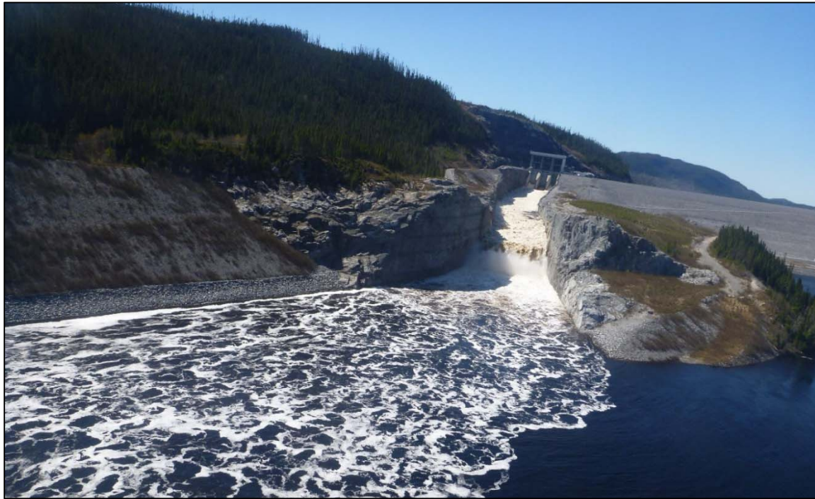
Photo 5 Évacuateur de crue du barrage de la Péribonka (H. Sénéchal, 29 mai 2018)
