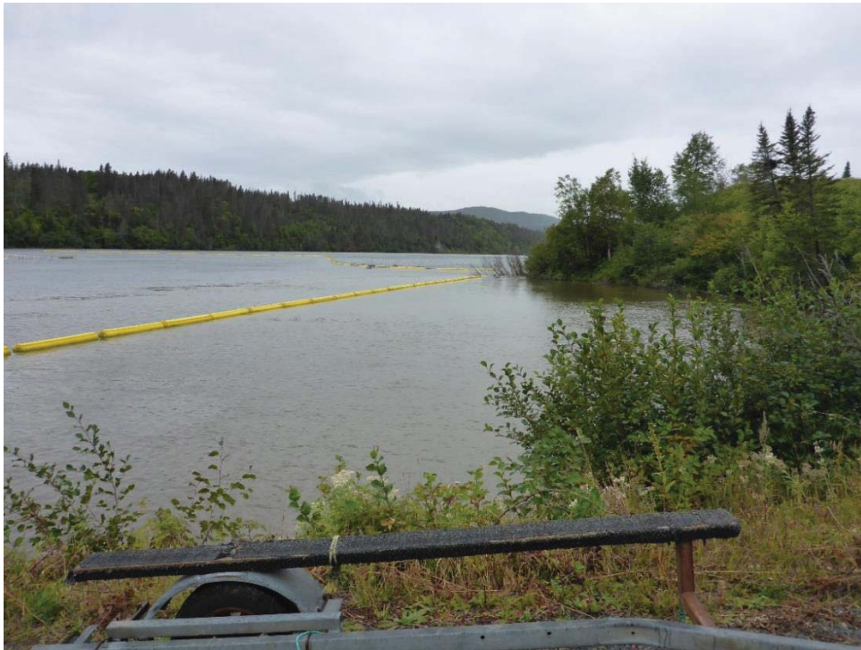
Photo 7 Accès à l'aval immédiat de la centrale de la Sainte-Marguerite-2 via la centrale de la Sainte-Marguerite-1, passage entre les estacades
