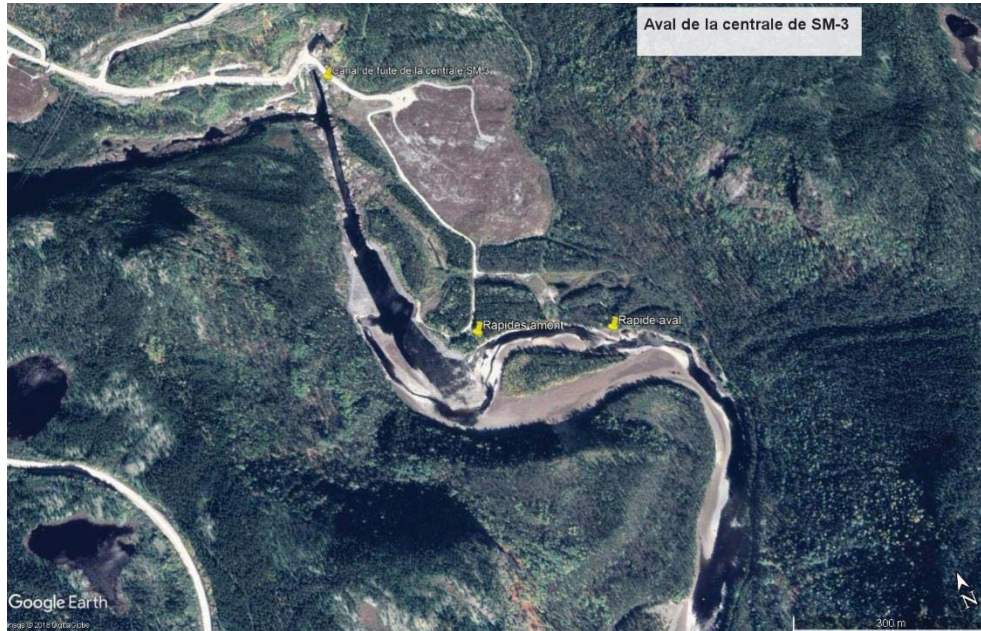
Photo 1 Vue aérienne de l'aval immédiat de la centrale de la Sainte-Marguerite-3
