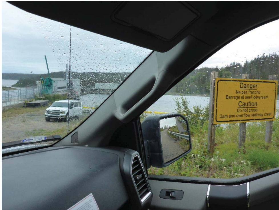
Photo 5 Accès à l'aval immédiat de la centrale de la Sainte-Marguerite-2 via la centrale de la Sainte-Marguerite-1, panneau d'avertissements
