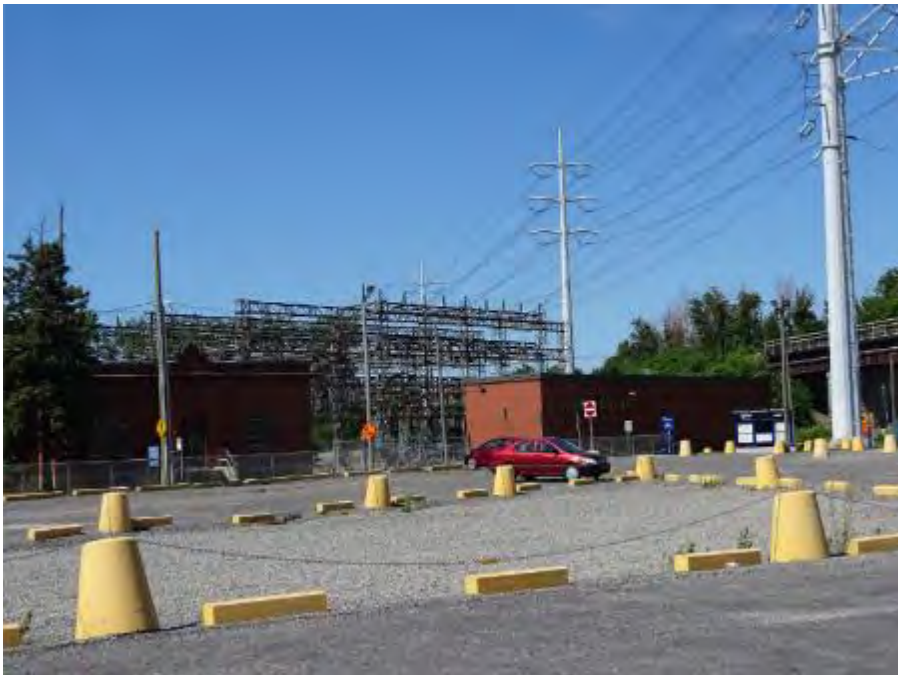
Photo 4-17 : Unité de paysage IN 5 – Depuis la gare du Canal vers le poste Rockfield et la ligne existante à remplacer, vers le nord géographique
