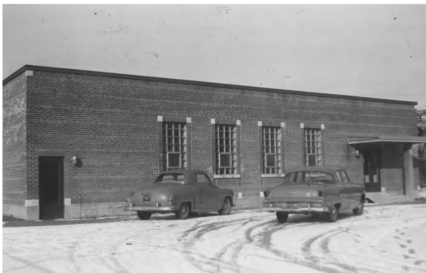
Photo 4-4 : Poste de Hampstead en 1955
