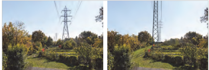
Simulation visuelle de la ligne électrique actuelle (à gauche) et projetée (à droite), à Montréal-Ouest
