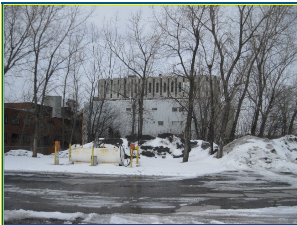
Photo 2 : Vue du réservoir de diesel, reposant sur une dalle de béton, et servant pour le ravitaillement de la machinerie, prise de vue vers le nord (14 février 2013).
