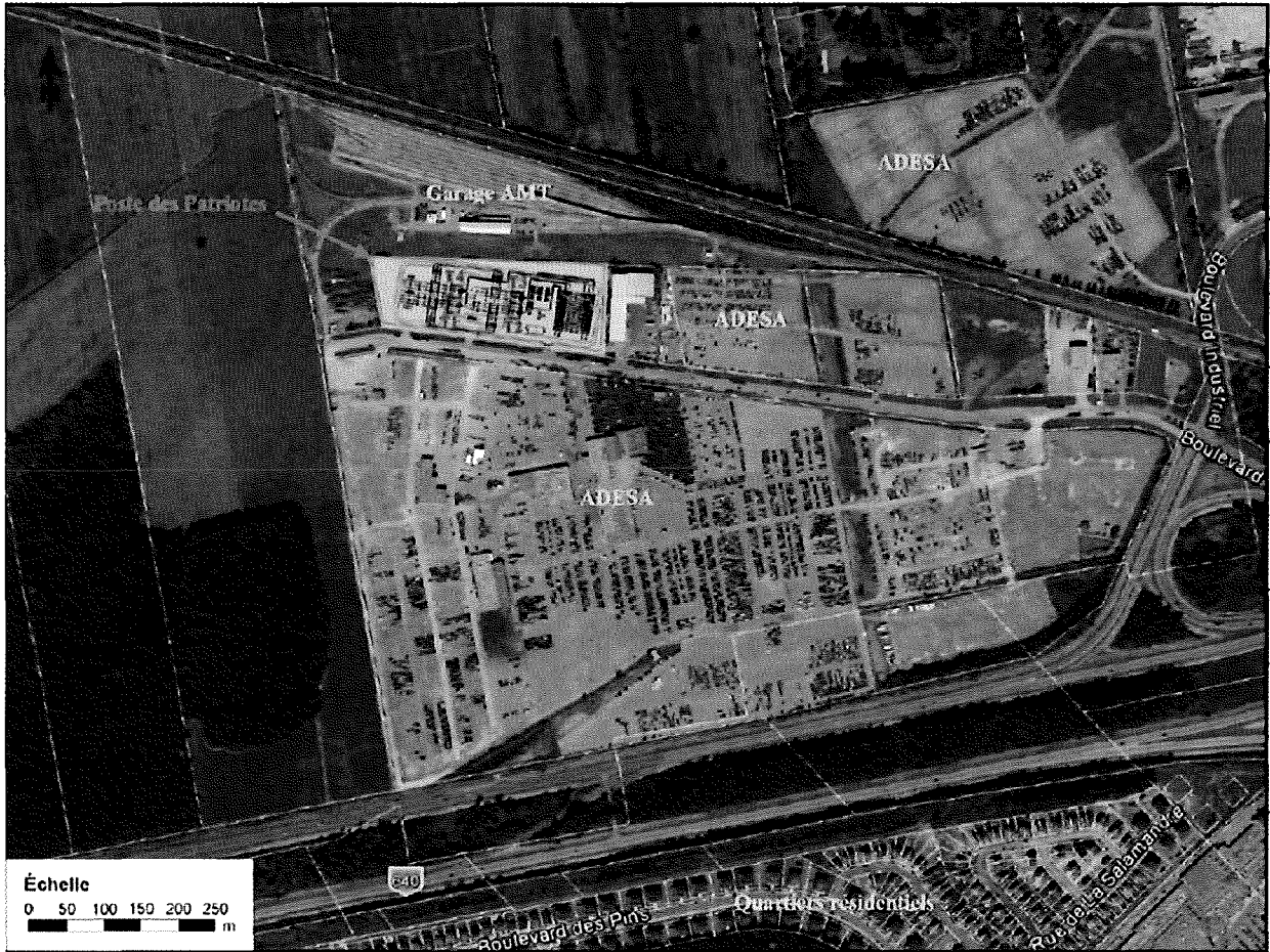
Figure 1 – Environnement du poste des Patriotes à 315-25 kV, Source : Poste des Patriotes à 315-25 kV et ligne d'alimentation à 315 kV – Étude d'impact sur l'environnement – Hydro-Québec, octobre 2017
