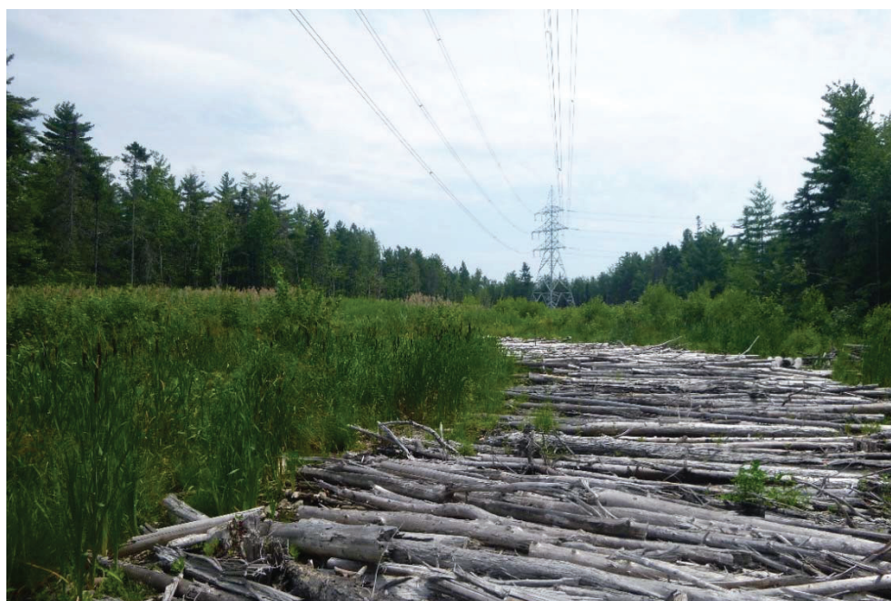
PHOTO 36 Fascines présentes dans l’emprise entre les pylônes 21 et 22 au sud du poste de Blainville — Suivi juillet 2016
