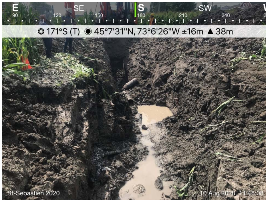
Dégagement du collecteur défectueux
