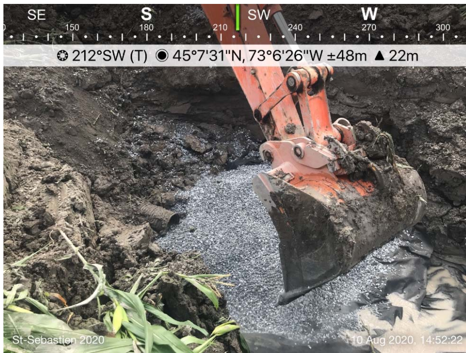
Préparation d'une nouvelle assise
