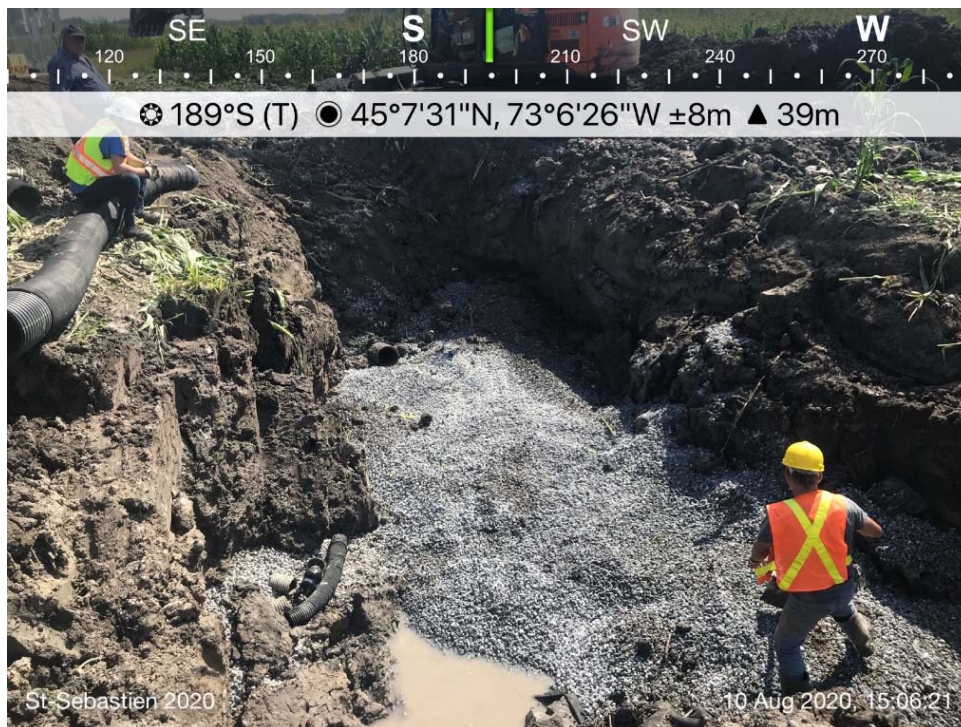
Préparation d'une nouvelle assise
