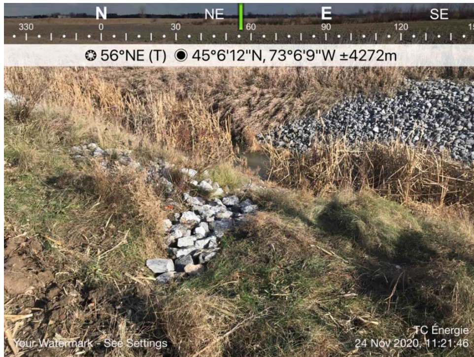
C. D. sans désignation – Travaux correctifs complétés
