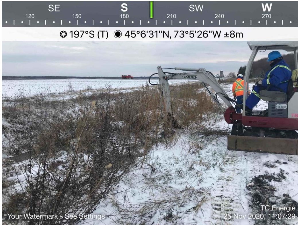
C.D. Ligne de Noyan – Retrait de la barrière à sédiments
