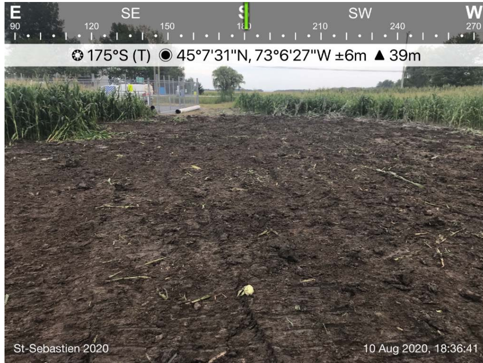
État du terrain à la fin des travaux
