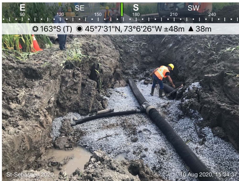
Remplacement du collecteur
