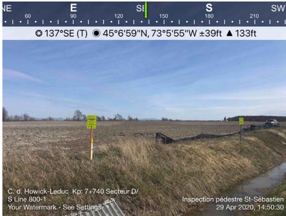
C. D. Howick – Leduc – Bonnes conditions au site de franchissement
