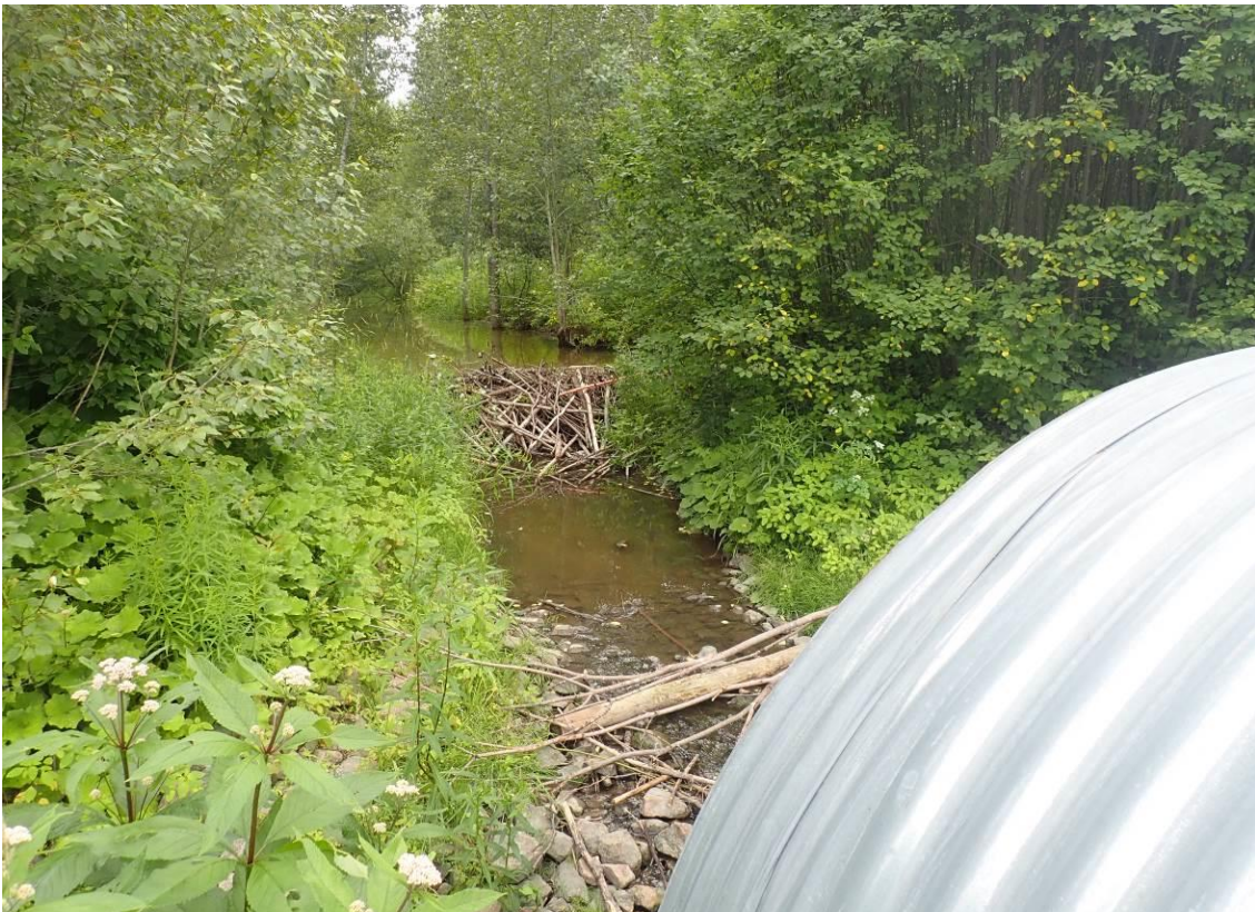
Photo 3-18 Barrage de castors situé en amont du ponceau du ruisseau Paradis traversant le chemin d'accès de la gare de triage nuisant à l'écoulement du cours d'eau et représentant un risque pour le ponceau
