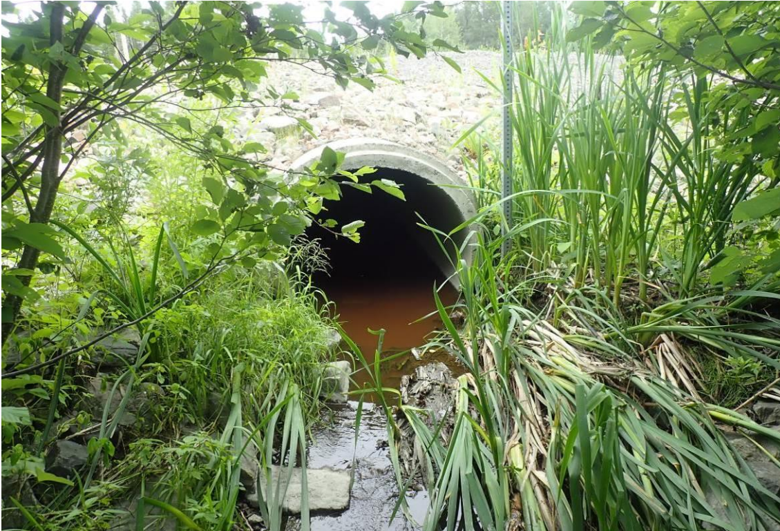
Photo 3-14 Barrage de castors situé tout juste en amont de l'extrémité est du ponceau du lot 4 012 685 (ponceau APS-P-0.57) nuisant à l'écoulement du cours d'eau intermittent et représentant un risque pour le ponceau
