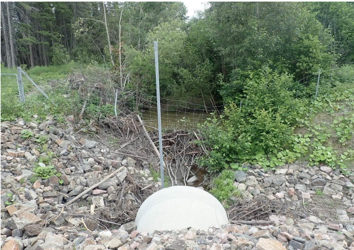
Photo 3-14 Barrage de castors situé tout juste en amont de l'extrémité est du ponceau du lot 4 012 685 (ponceau APS-P-0.57) nuisant à l'écoulement du cours d'eau intermittent et représentant un risque pour le ponceau
