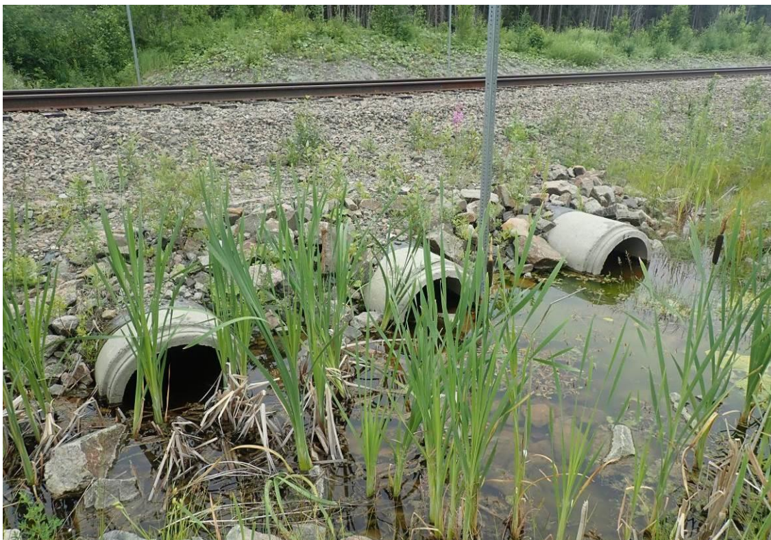
Photo 3-16 Ponceaux en parallèle situé à la limite nord du lot 4 012 683 (ponceau APS-P-0.33) assurant un lien hydrique de part et d'autre de la desserte ferroviaire (végétation aquatique plus abondante qu'en 2018)
