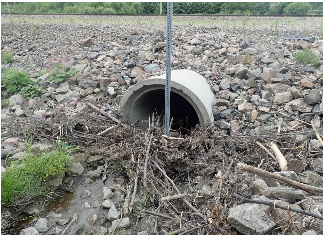
Photo 3-16 Ponceaux en parallèle situé à la limite nord du lot 4 012 683 (ponceau APS-P-0.33) assurant un lien hydrique de part et d'autre de la desserte ferroviaire (végétation aquatique plus abondante qu'en 2018)
