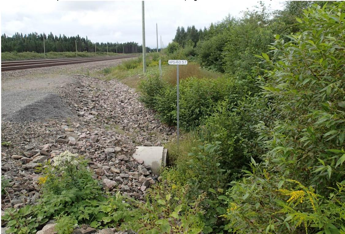
**Photo 3-14 :** Ponceaux en parallèle situés à la limite nord du lot 4 012 683 assurant un lien hydraulique de part et d'autre de la desserte ferroviaire (végétation aquatique plus abondante qu'en 2016)
