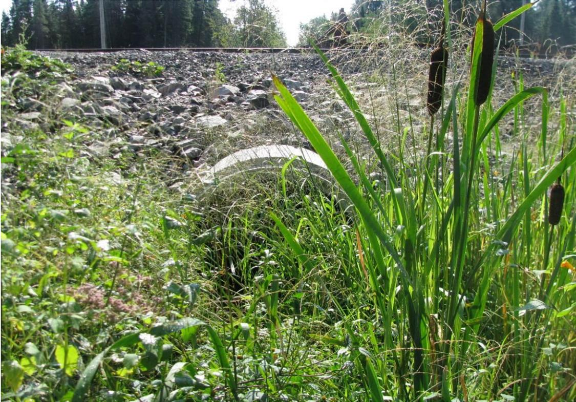
**Photo 3-14 :** Ponceaux en parallèle situés à la limite nord du lot 4 012 683 assurant un lien hydraulique de part et d'autre de la desserte ferroviaire
