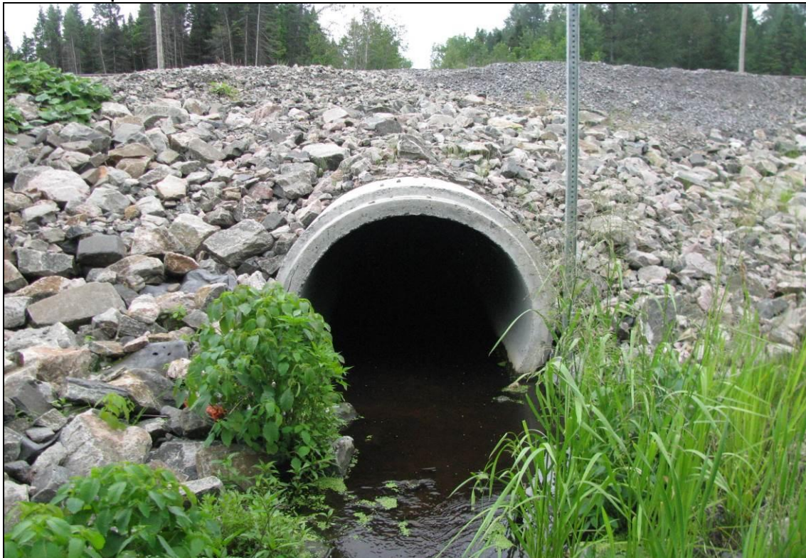
Photo 3-1 : Ponceau surdimensionné situé à limite nord du lot 4 012 685 assurant un lien hydraulique de part et d'autre de la desserte ferroviaire
