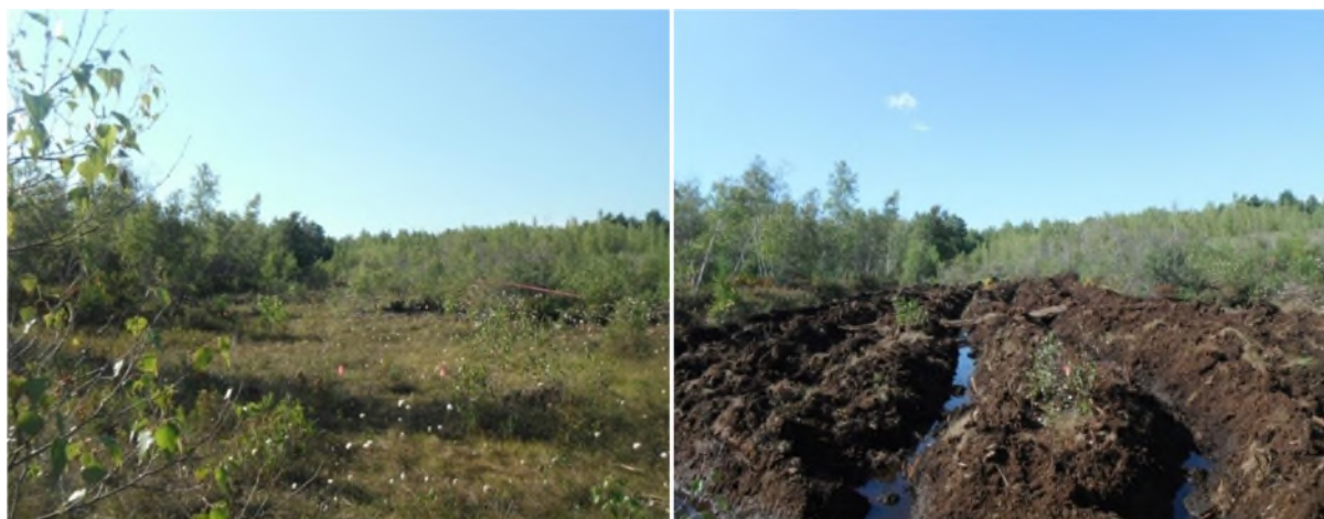
Figure 3. Zone 1 avant et après le creusage des sillons à l'origine des buttes de plantation
