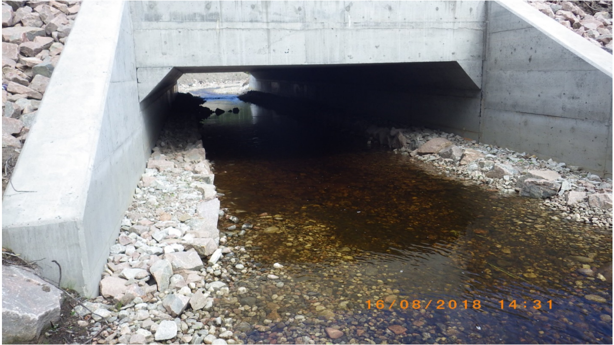
Photo 15 : Vue n° 3 montrant l'intérieur du ponceau en direction de l'amont
