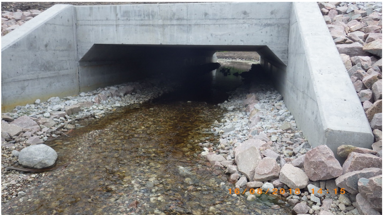
Photo 16 : Vue n° 4 montrant l'intérieur du ponceau en direction de l'aval
