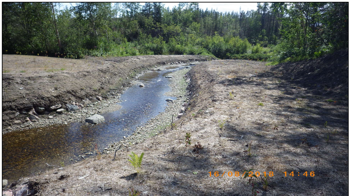
Photo 5 : Blocs abris dans le tronçon reconstitué en aval du pontceau
