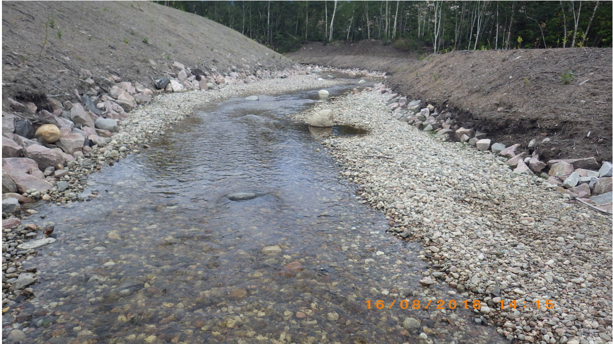
Photo 17 : Vue n° 5 montrant le raccordement amont en direction de l'amont
