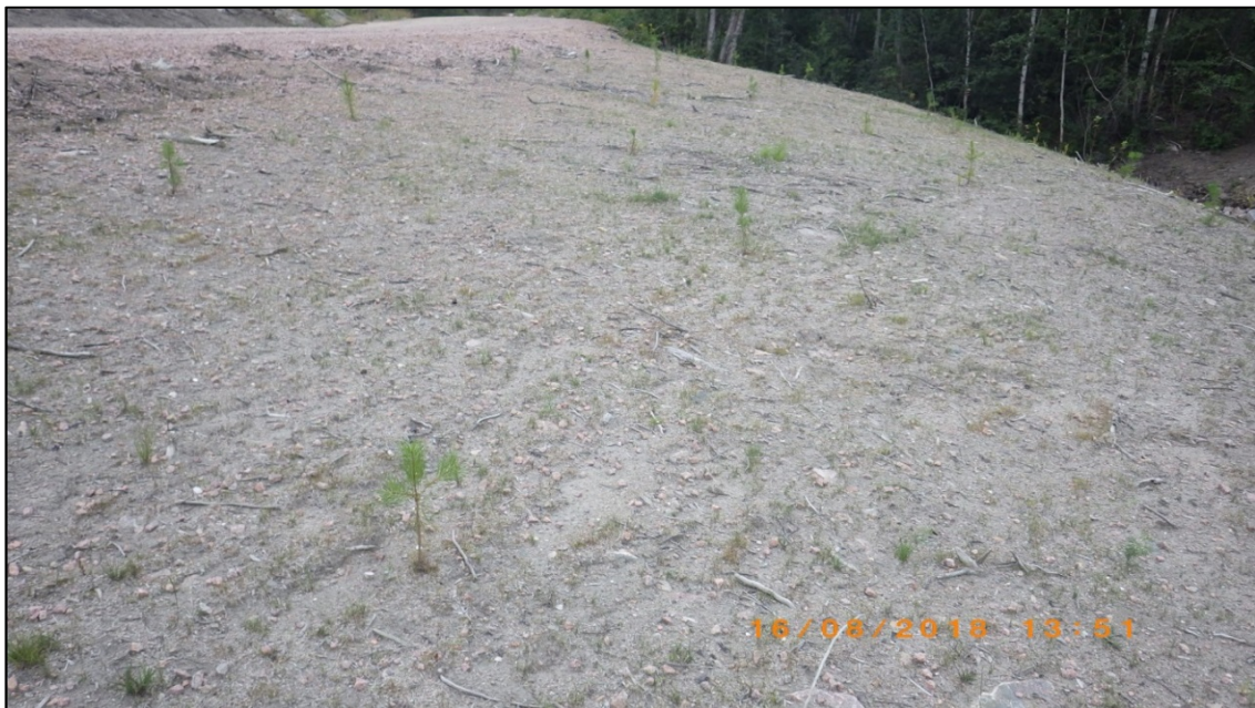
Photo 11 : Végétation arbustive du tronçon reconstitué en amont du ponceau
