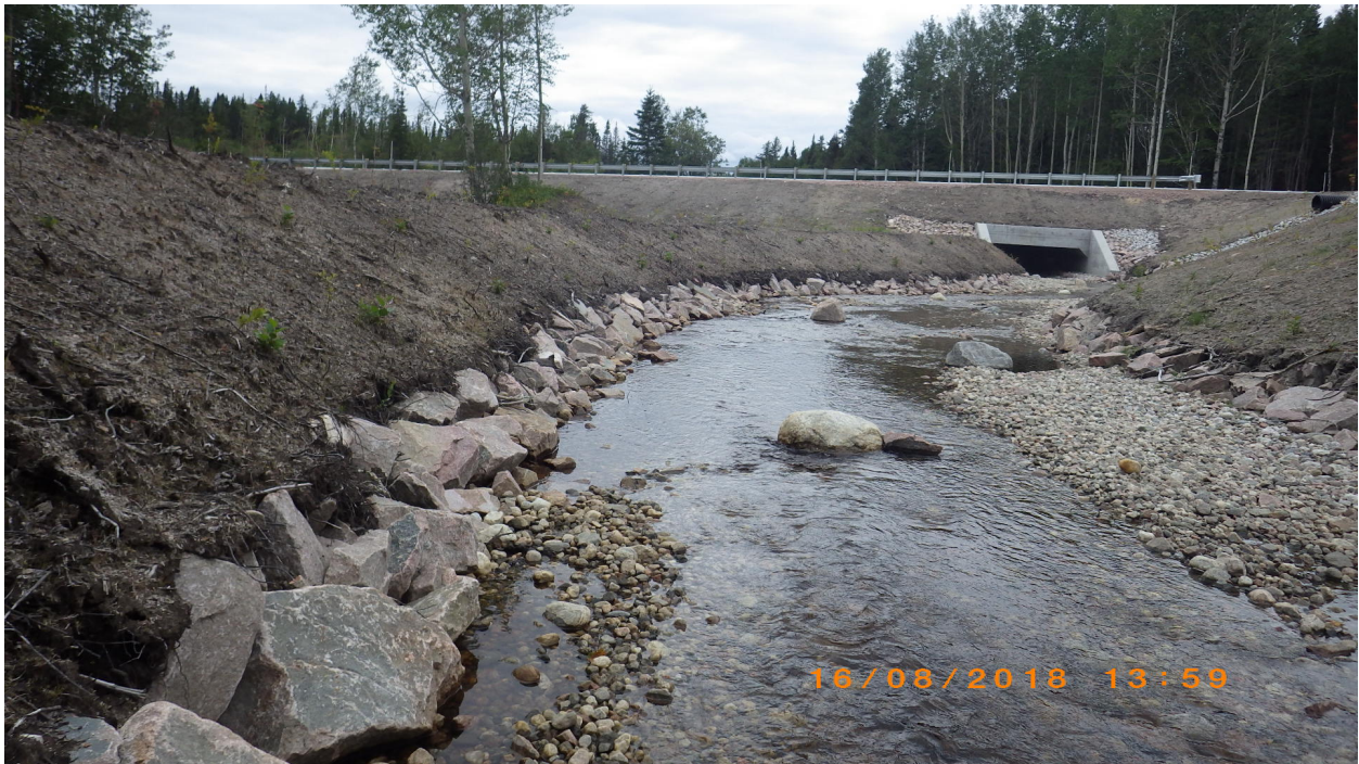
Photo 18 : Vue n° 6 montrant le raccordement amont et de l'extrémité amont du ponceau en direction aval
