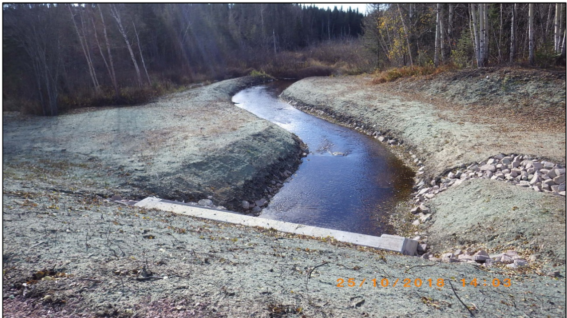
Photo 9 : Aménagement paysager du tronçon reconstitué en aval du ponceau
