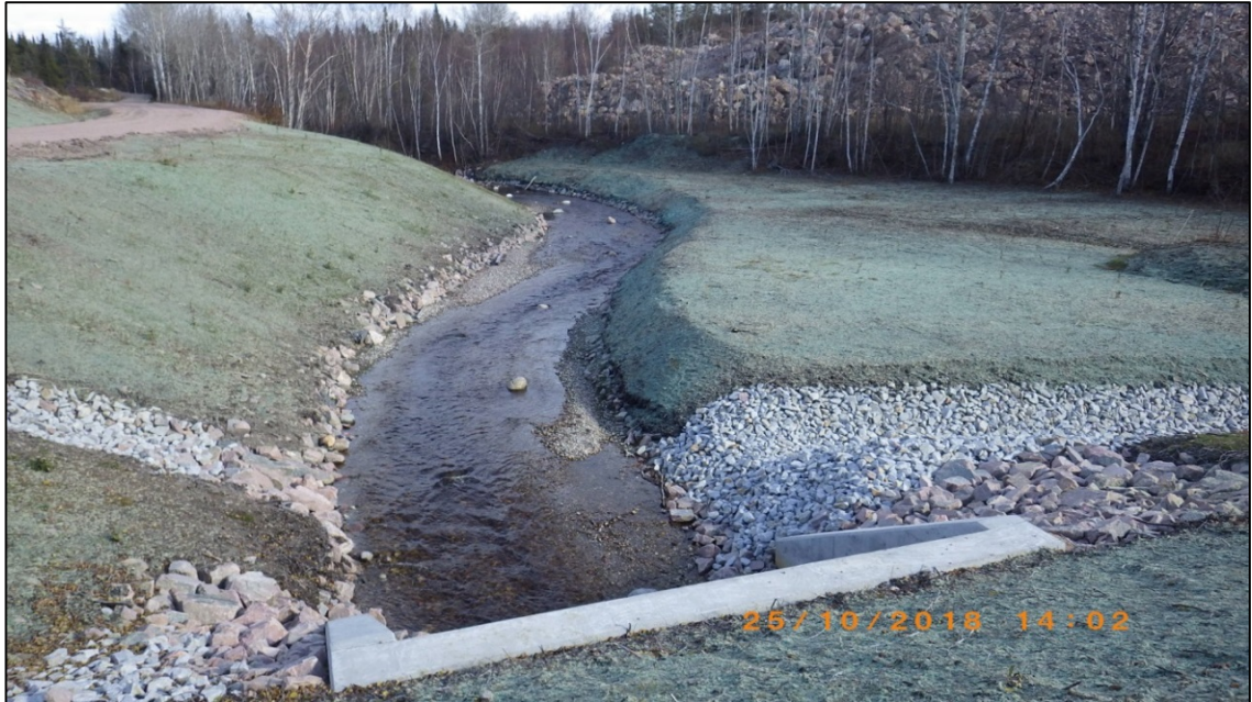
Photo 8 : Aménagement paysager du tronçon reconstitué en amont du ponceau
