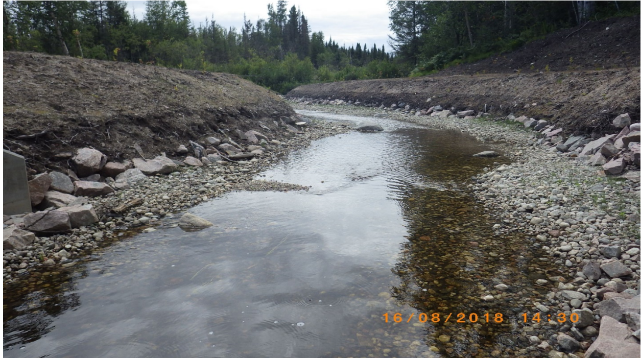
Photo 14 : Vue n° 2 montrant le raccordement aval en direction de l'aval
