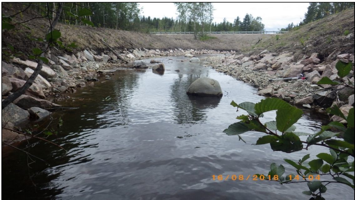
Photo 7 : Blocs abris dans le tronçon reconstitué en amont du ponceau
