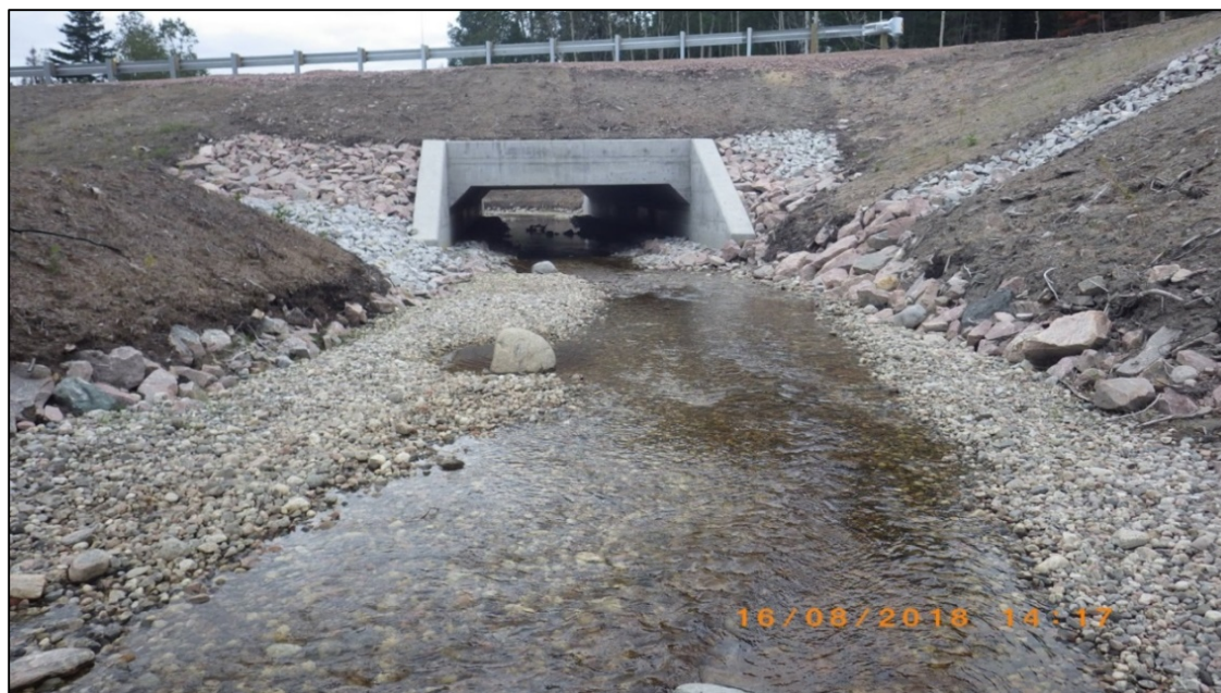
Photo 1 : Vue de l'amont du ponceau
