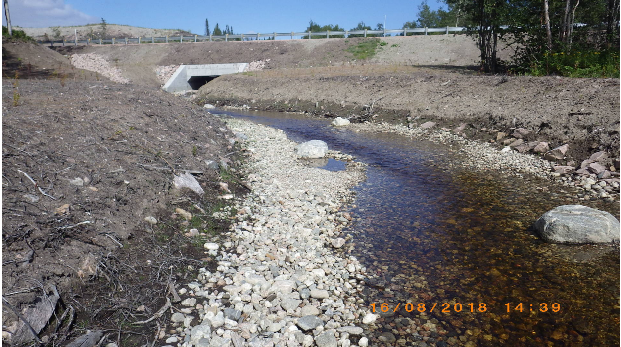
Photo 13 : Vue n° 1 montrant le raccordement aval et de l'extrémité aval du ponceau en direction de l'amont
