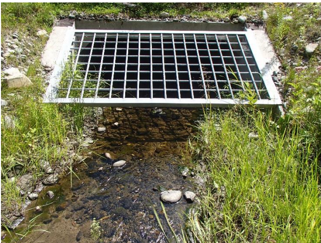
5. Entrée nord du ponceau no. 3 en période sèche (13 août 2018).
