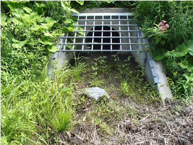
3. Entrée nord du ponceau no. 2 en période sèche (13 août 2018).
