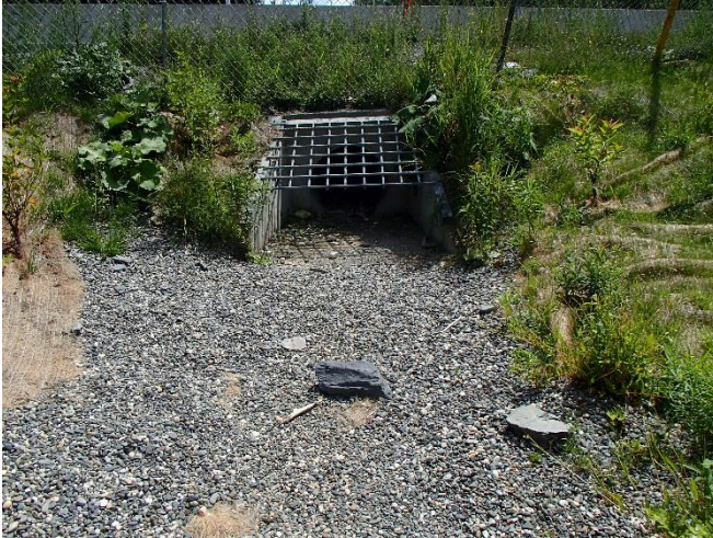
1. Entrée nord du ponceau no. 1 en période sèche (13 août 2018).
