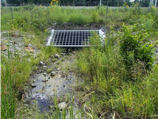
7. Entrée nord du ponceau no. 4 en période sèche (13 août 2018).
