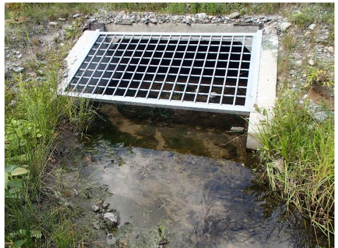
6. Entrée sud du ponceau no. 3 en période sèche (13 août 2018).
