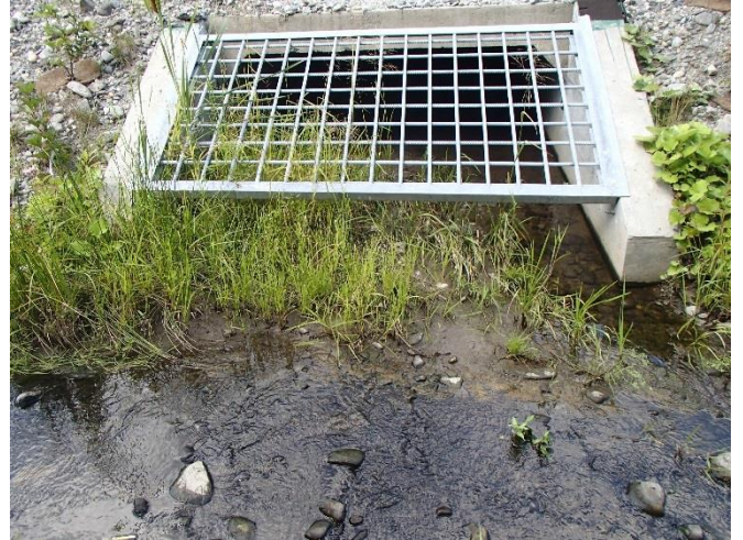
8. Entrée sud du ponceau no. 4 en période sèche (13 août 2018).
