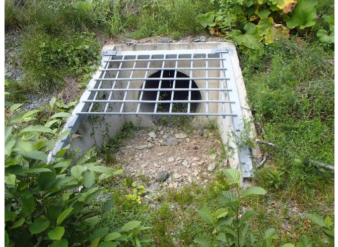
2. Entrée sud du ponceau no. 1 en période sèche (13 août 2018).
