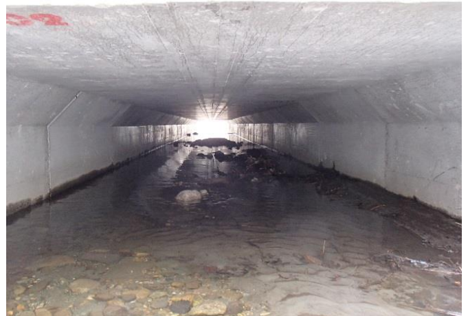
10. Vue intérieure du ponceau 4.
