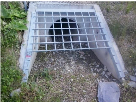
Fig. 4. Grille de protection d'un ponceau circulaire.
