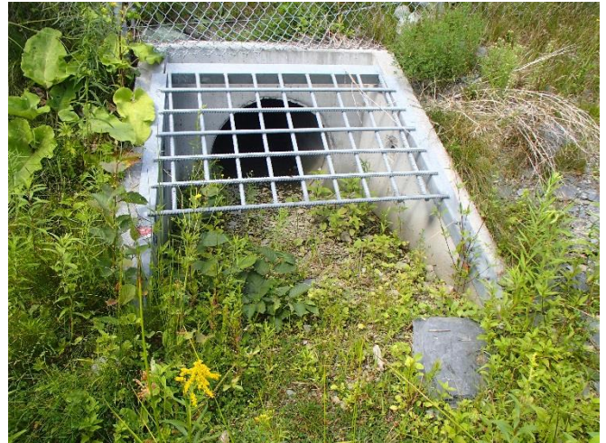
4. Entrée sud du ponceau no. 2 en période sèche (13 août 2018).
