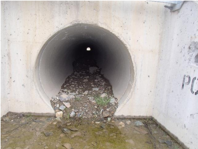
9. Vue intérieure du ponceau 2 à sec.
