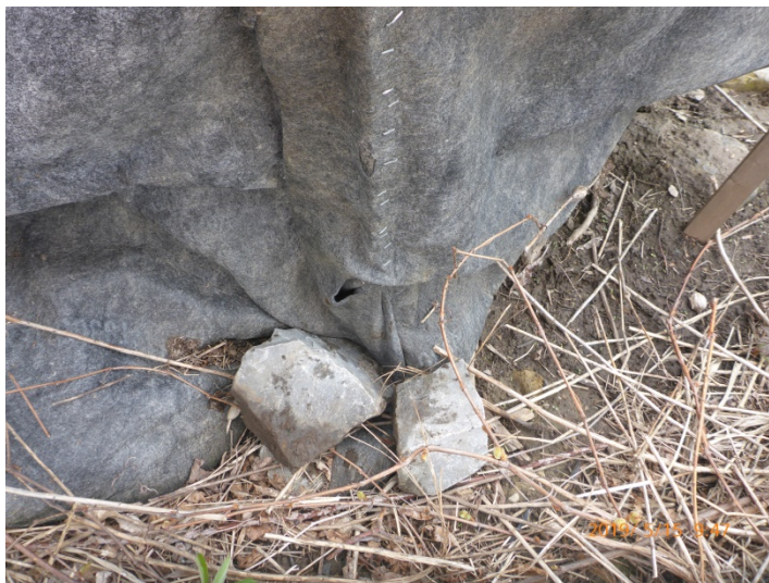
Figure 2.6 : Réparation de l'hibernacle H1 après constatation d'une ouverture dans la barrière
