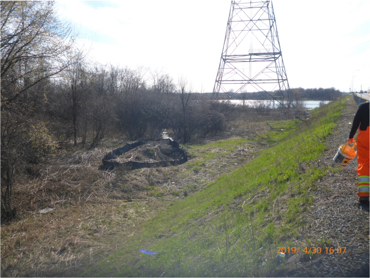
ANNEXE 11 : Vu d'ensemble du talus routier et du bas de talus démontrant une végétation plus faible dans le talus routier
