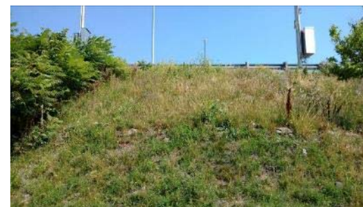
Photo: 17: Zone à replanter (0+080)
