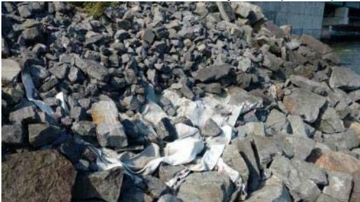
Photo 10 : Membrane apparente (0+140)
