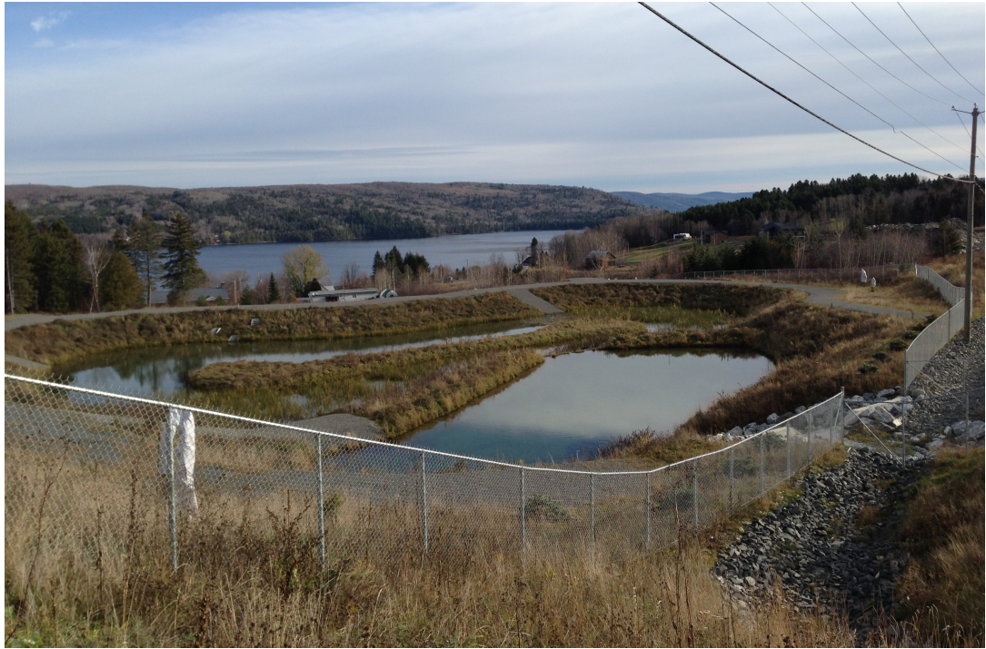
Photographie 10-1 : Aperçu du bassin 10+470 situé au kilomètre 28,5
