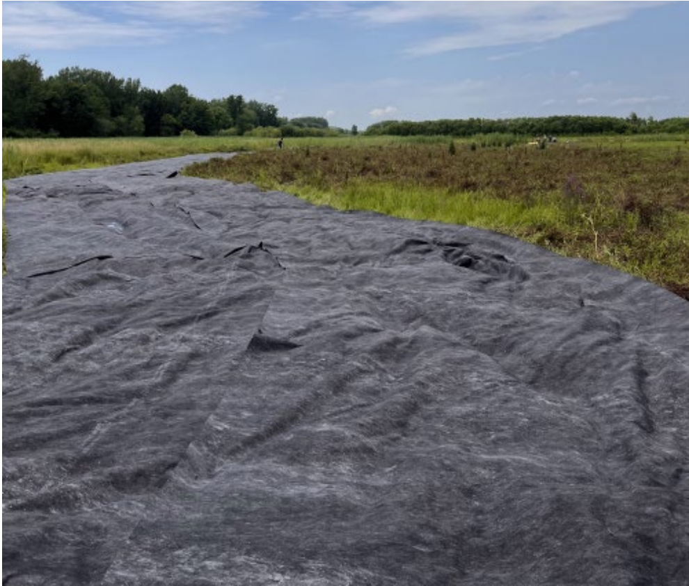
Figure 12. Bandes de géotextile installées dans le MR7
