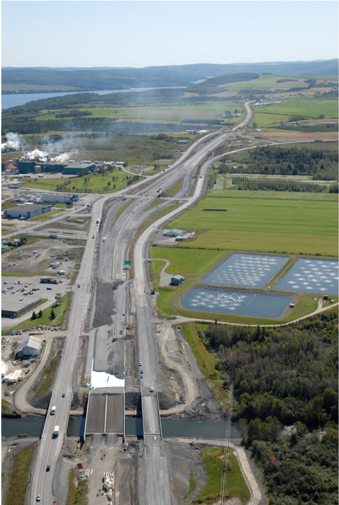
Photographie 1.1 : Vue aérienne des travaux au sud de la rivière Cabano (source MTQ)
