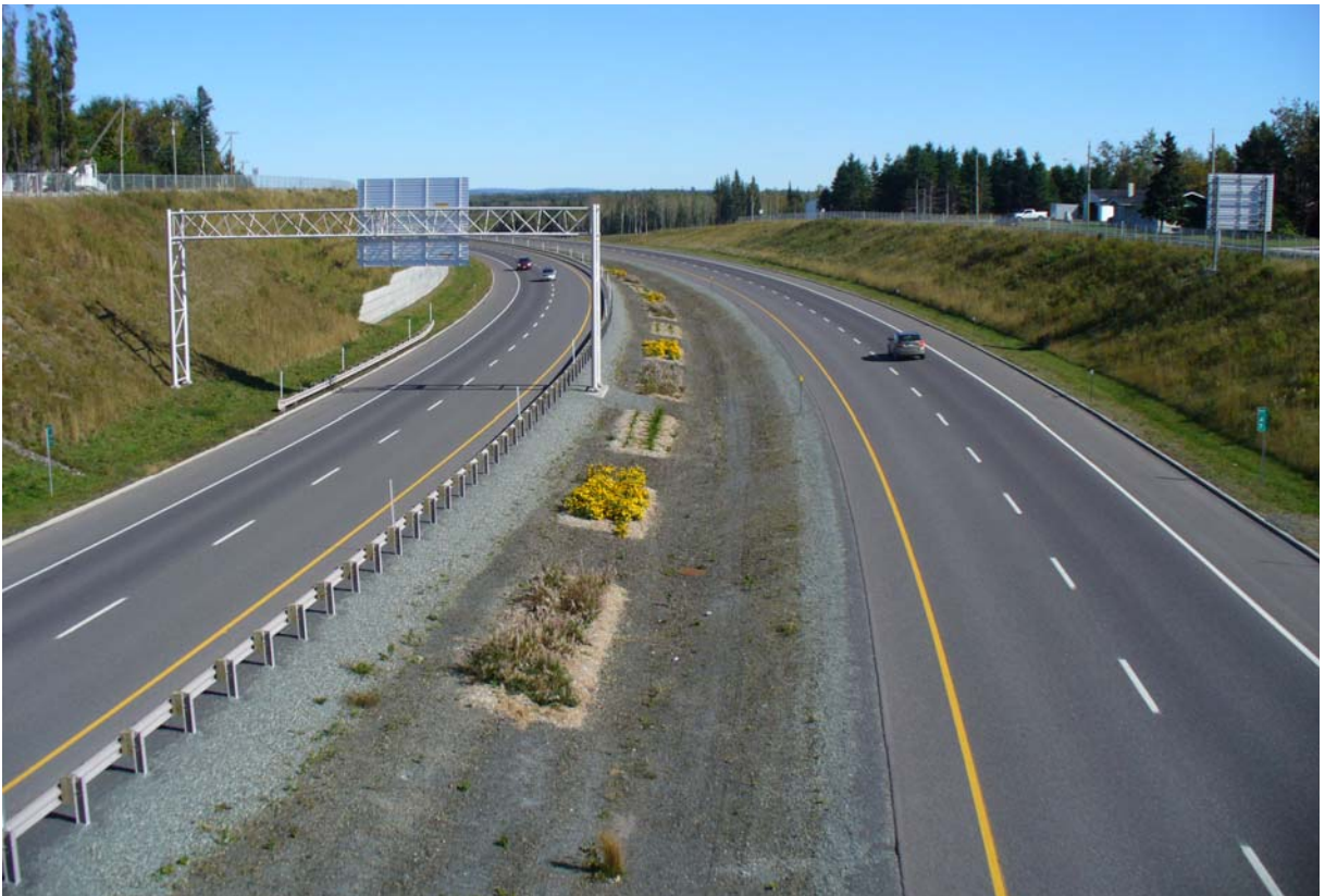
Photographie n°2.2 : Vue des nouvelles voies de l'autoroute au sud de la rue Raymond
