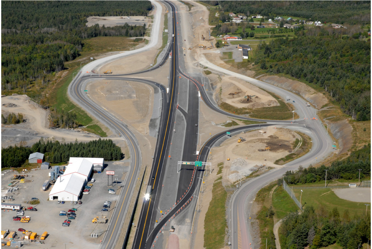
Photographie n°2.1 : Vue aérienne des travaux au nord de la rue Raymond (source MTQ)
