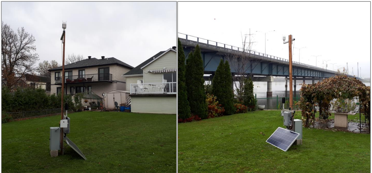
Figure 2 : Station installée à l'arrière du 7195 boulevard Gouin Est
