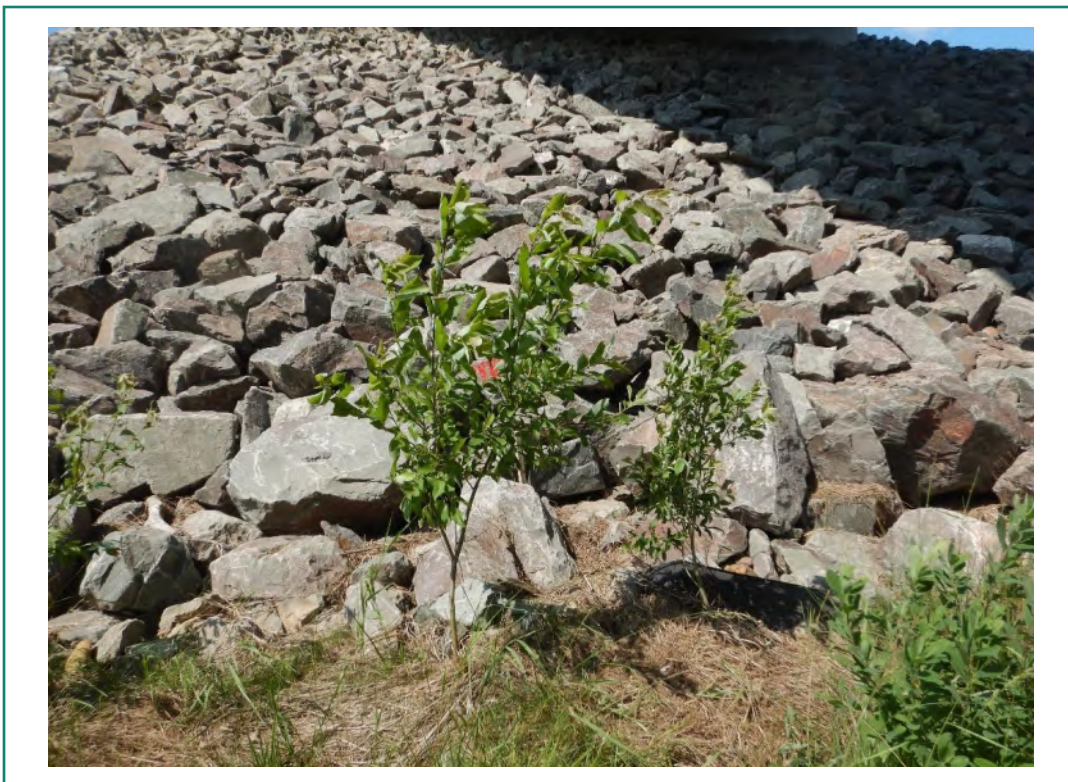
Photo 10 : Zone du chenal, transect TT4, vue vers la rive
