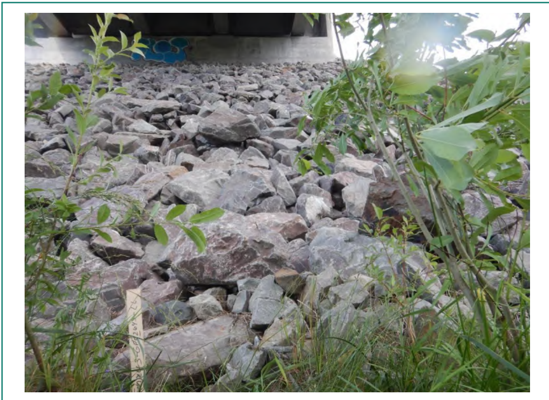
Photo 8 : Zone du chenal, transect TT3, vue vers la rive
