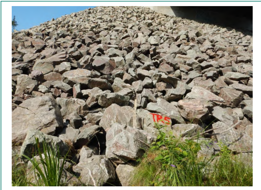
Photo 12 : Zone du chenal, transect TT5, vue vers la rive
