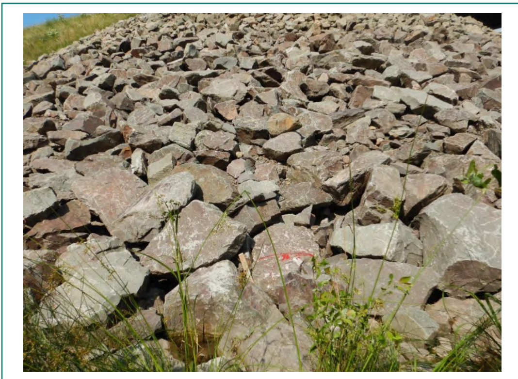
Photo 14 : Zone du chenal, transect TT6, vue vers la rive
