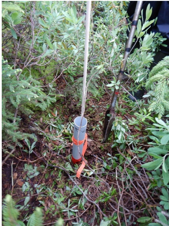
Photo 3 : Installation d'un puits dans la tourbière (T3-8m)
