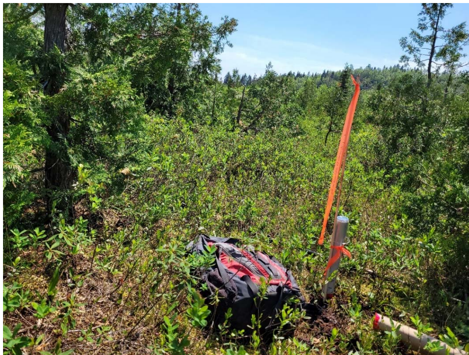
Photo 4 : Installation d'un puits dans la tourbière (T4-8m)
