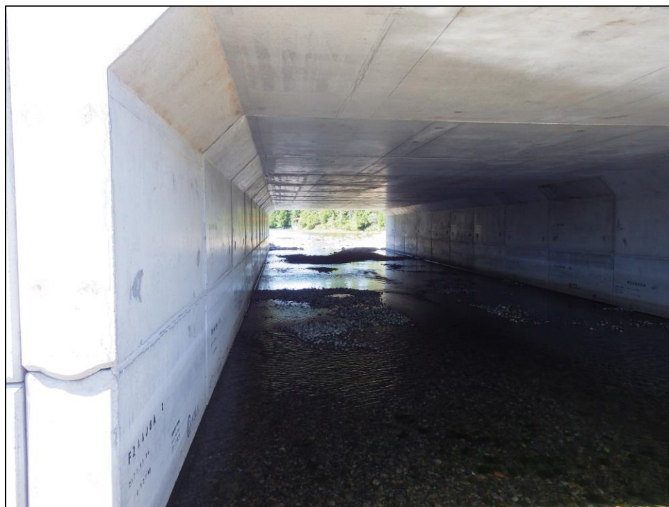
Photo 3 Intérieur du ponceau, vue de l'aval
