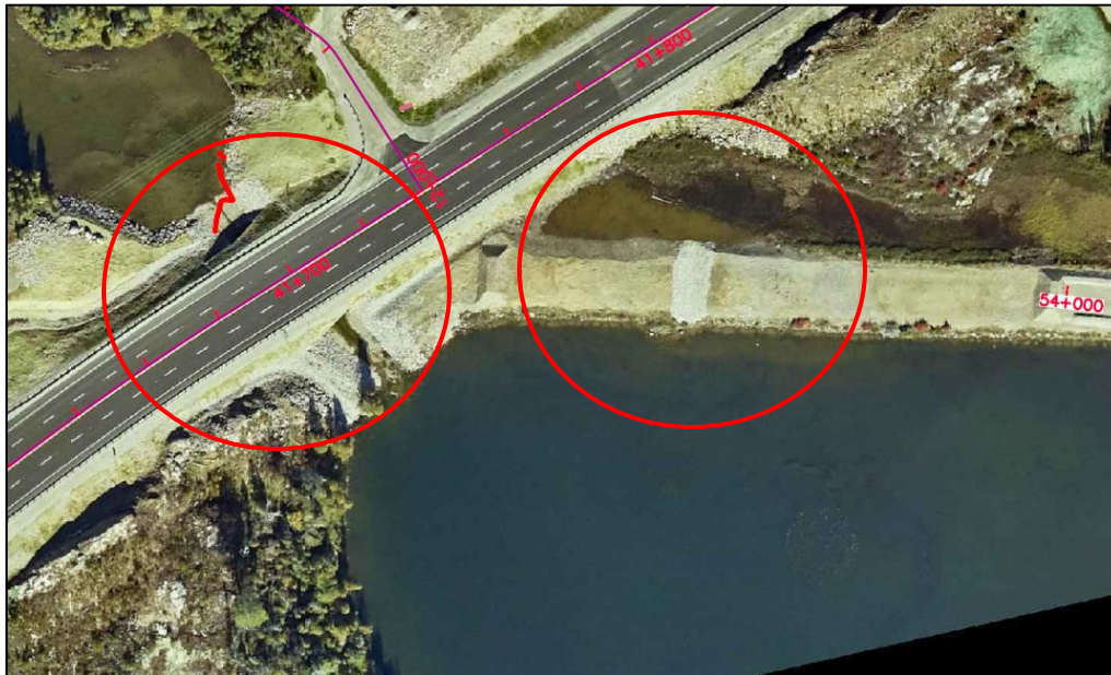
Figure 1. Vue aérienne des sites aménagés durant les travaux
