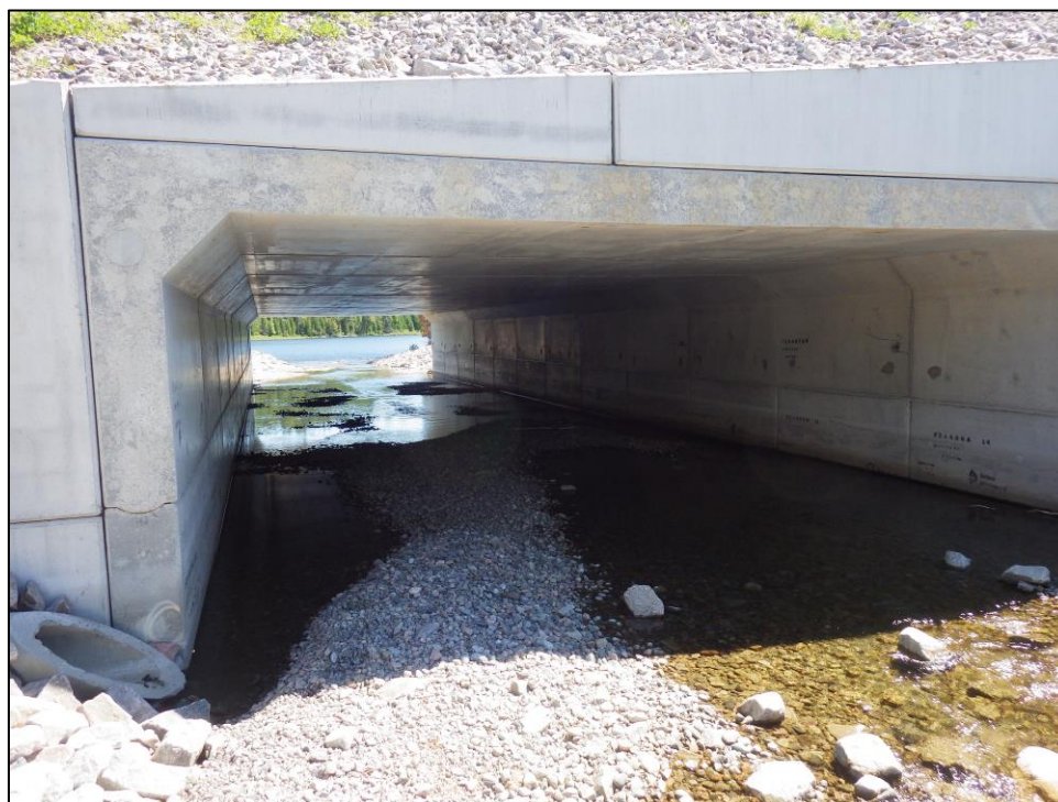
Photo 4 Intérieur du ponceau, vue de l'amont
