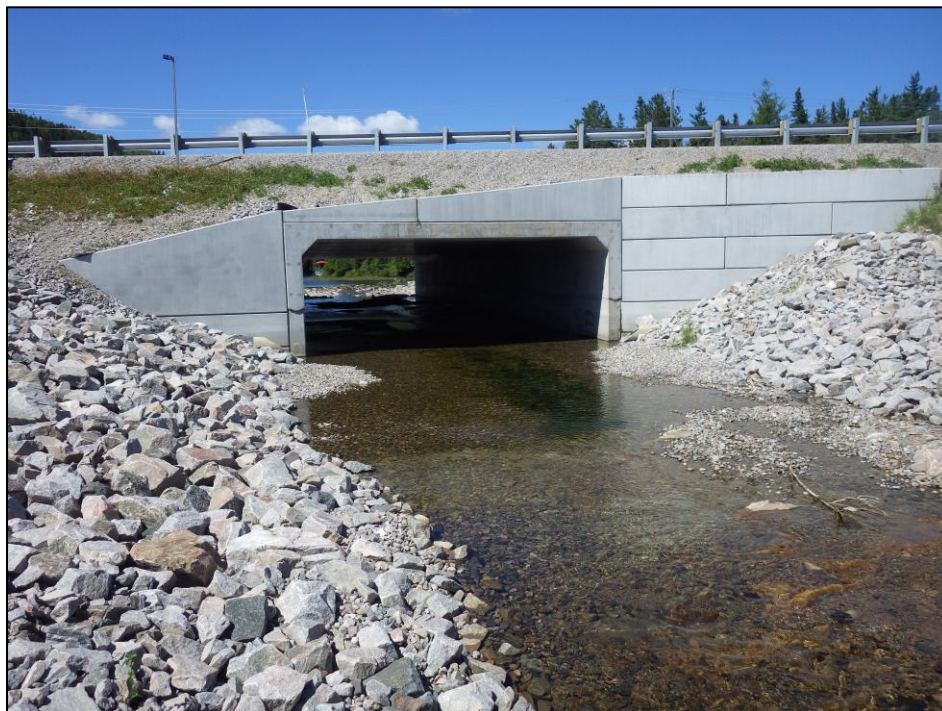
photo 1 Raccordement avec le lac Jérôme et l'extrémité du ponceau, Vue de l'aval
