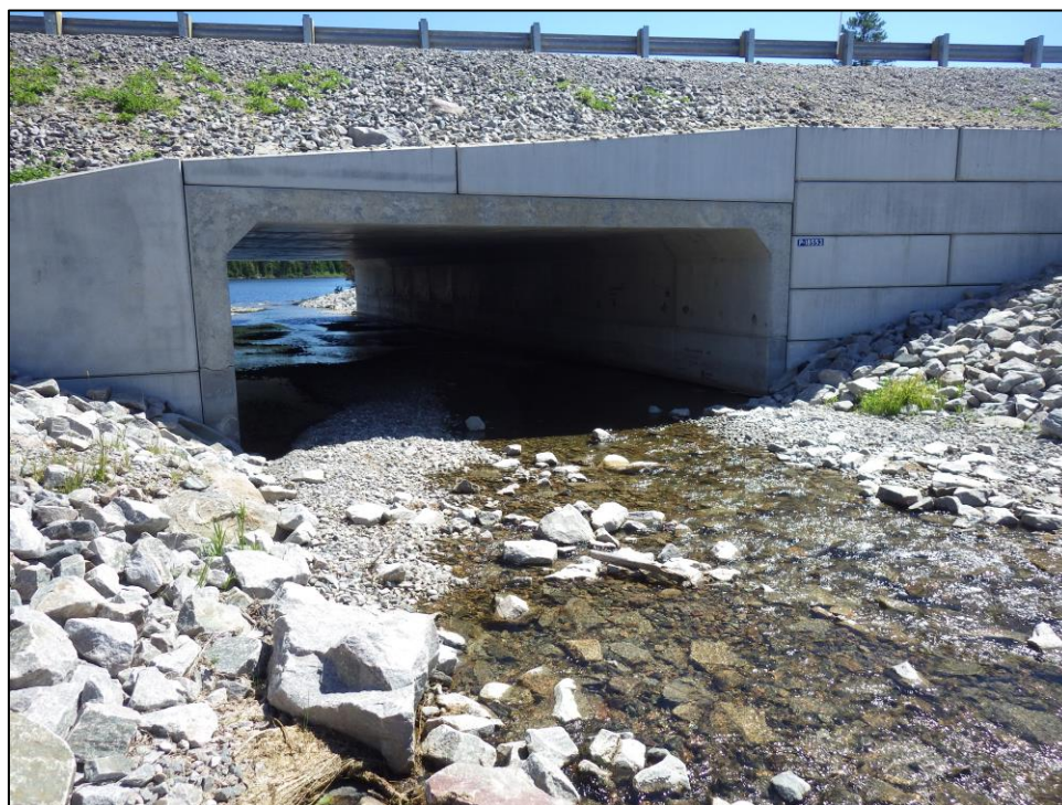
Photo 6 Raccordement amont et entrée ponceau, vue de l'amont
