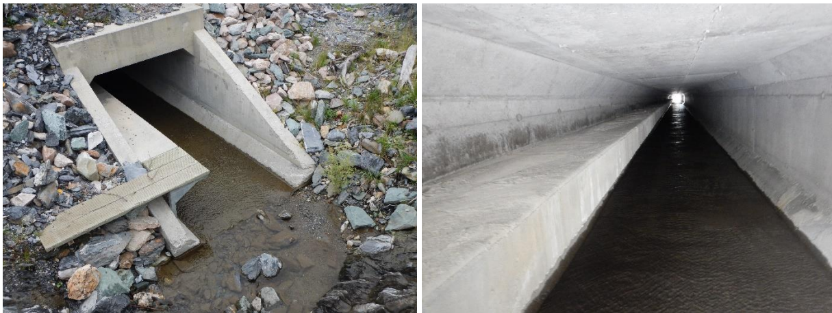
Figure 4 Extrémité amont et intérieur du ponceau 6
