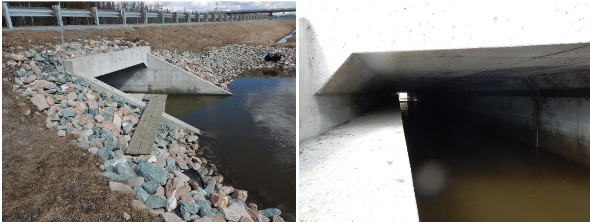
Figure 2 Extrémité aval et intérieur du ponceau 3
