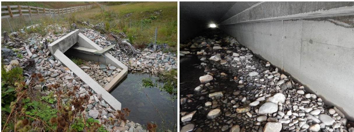
Figure 1 Extrémité aval et intérieur du ponceau 1
