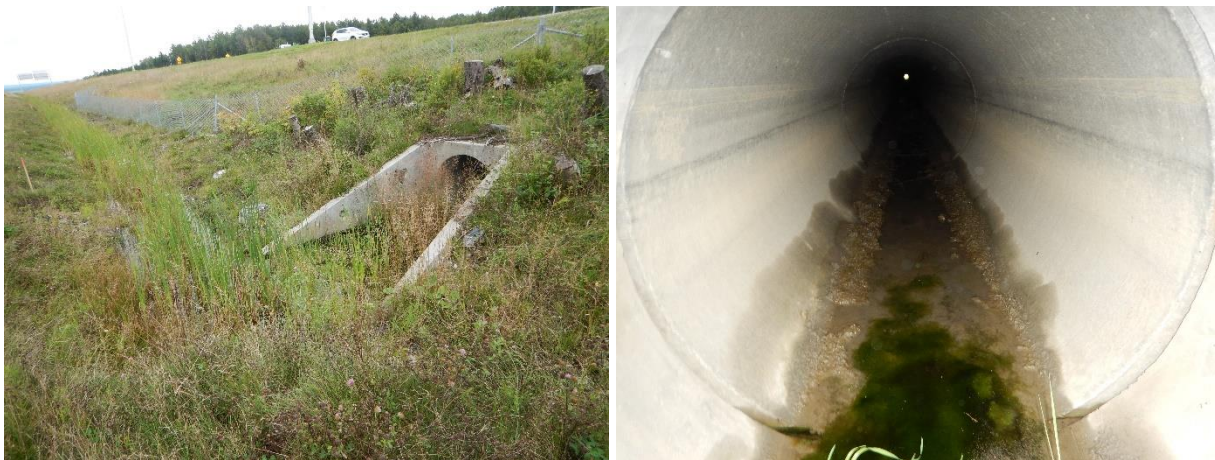
Figure 3 Extrémité nord et intérieur du ponceau 5
