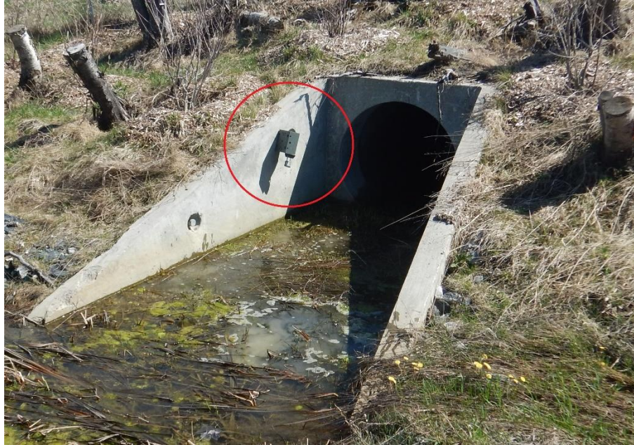
Figure 6 Caméra 5A, pointant vers l'extrémité du ponceau 5
