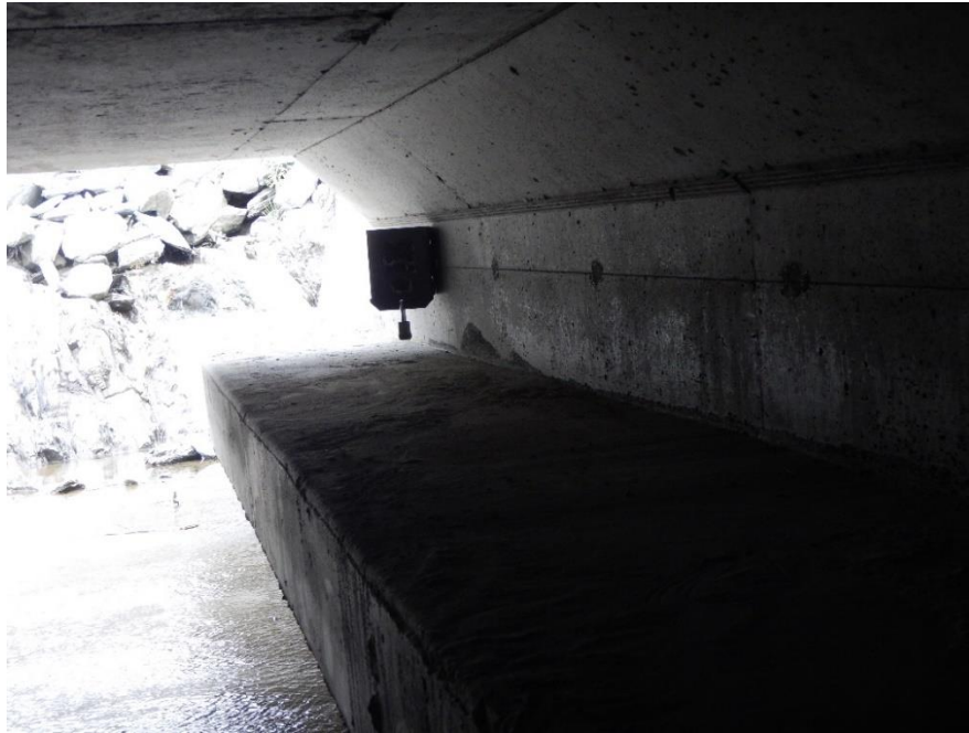
Figure 7 Caméra 6A, pointant vers l'intérieur du ponceau 6
