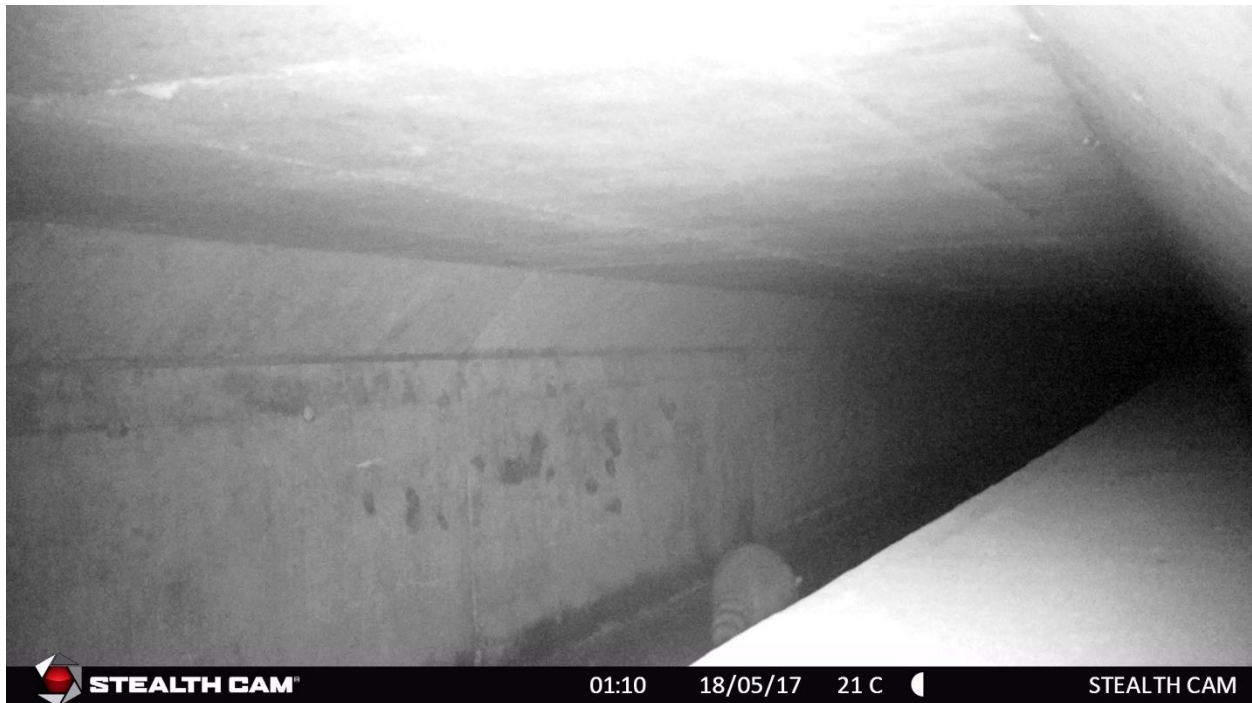
Figure 8 Raton laveur traversant le ponceau 6 sans utiliser la tablette
